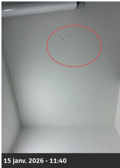
Photo 28 • Salle de bains / Plafond
