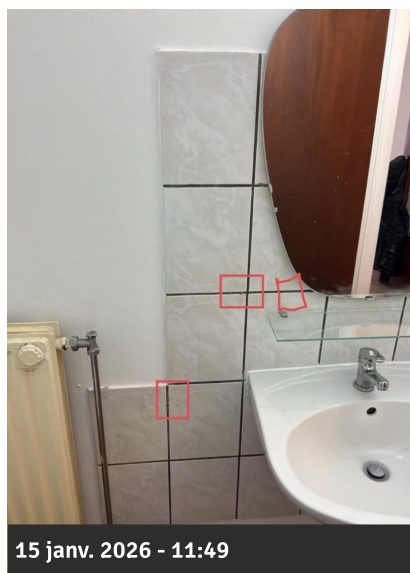
Photo 23 • Salle de bains / Mur
