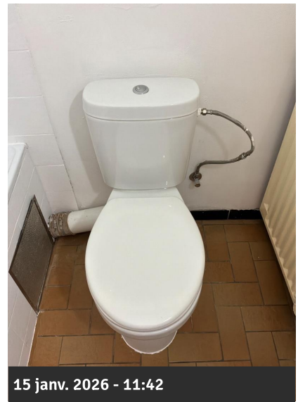
Photo 35 • Salle de bains / WC
