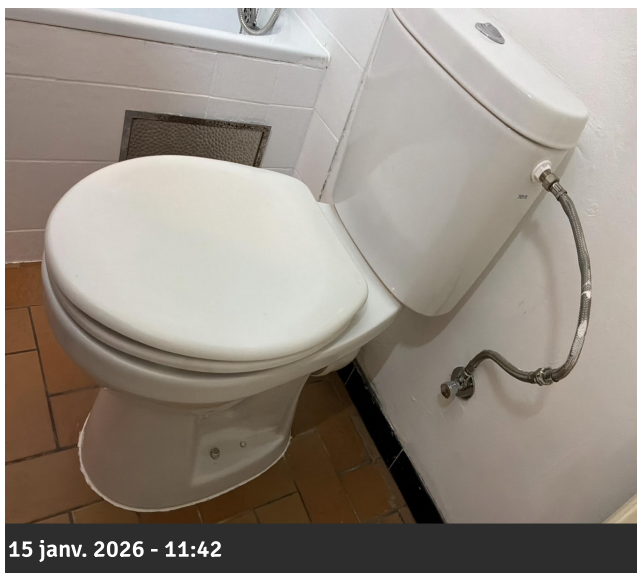
Photo 36 • Salle de bains / WC
