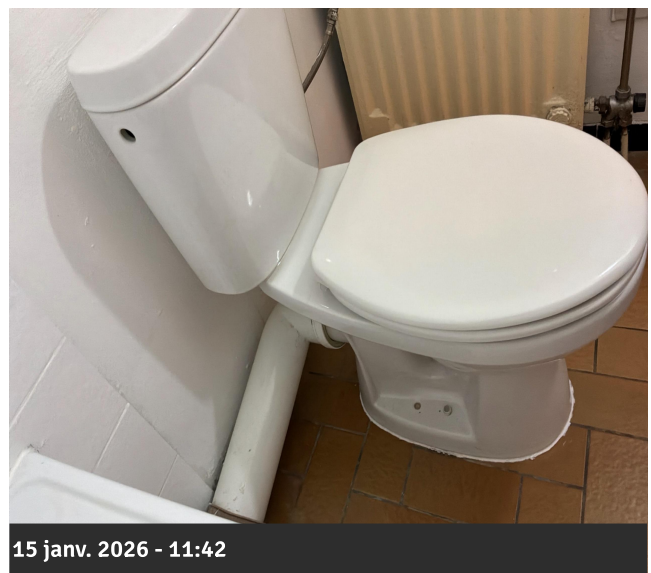
Photo 37 • Salle de bains / WC
