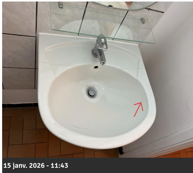
Photo 39 • Salle de bains / Lavabo
