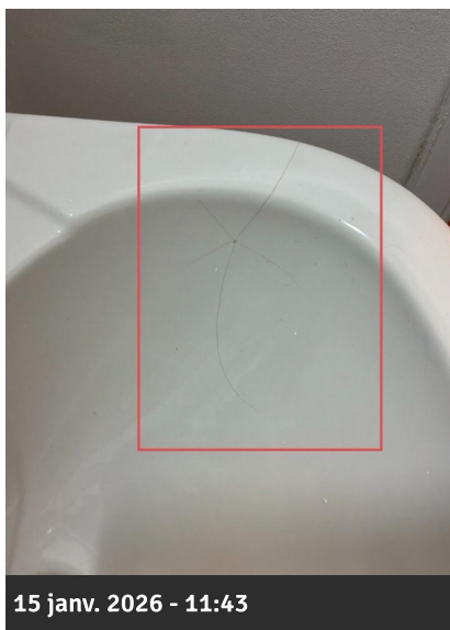
Photo 40 • Salle de bains / Lavabo
