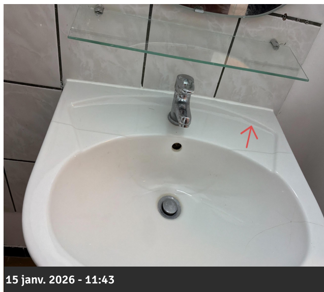
Photo 41 • Salle de bains / Lavabo
