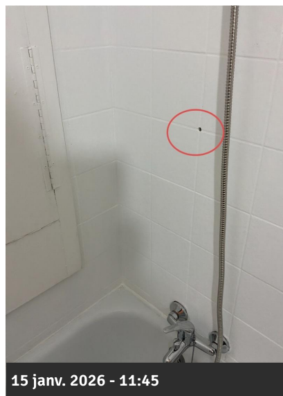
Photo 20 • Salle de bains / Mur
