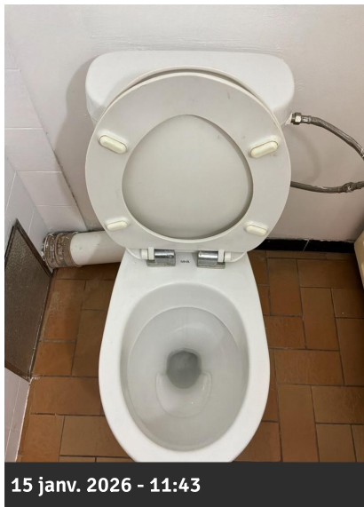
Photo 38 • Salle de bains / WC
