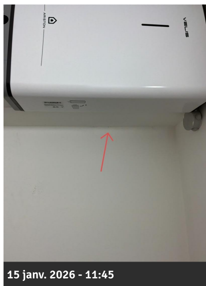
Photo 22 • Salle de bains / Mur
