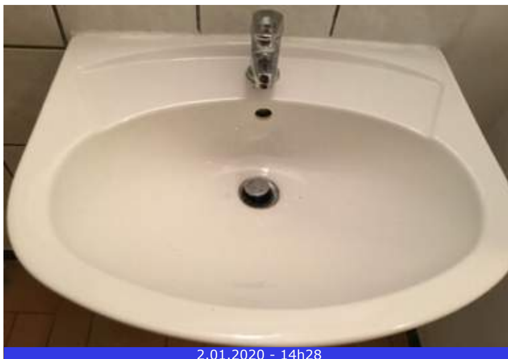
Photo 63 (Salle de bains / Lavabo / Bon état)
