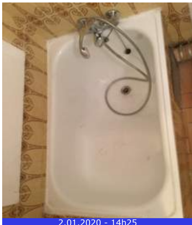
Photo 58 (Salle de bains / Baignoire / Bon état)
