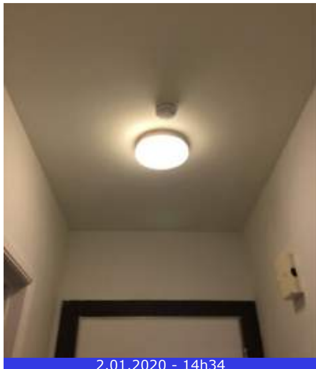
Photo 11 (Hall / Plafond / Bon état)
