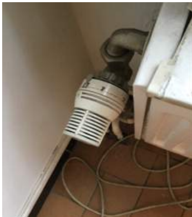
Photo 24 (Séjour / Radiateur(s) / Bon état)
