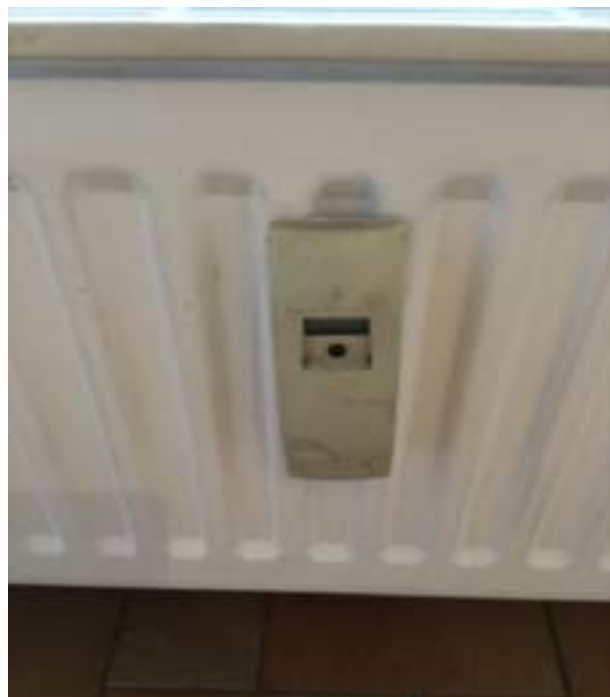
Photo 25 (Séjour / Radiateur(s) / Bon état)
