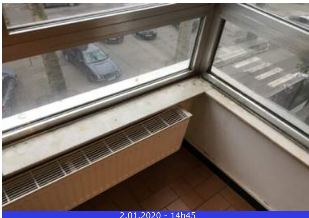
Photo 29 (Séjour / Fenêtre(s) / Bon état)
