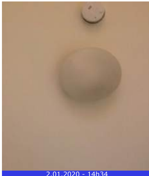
Photo 12 (Hall / Point lumineux / Bon état)
