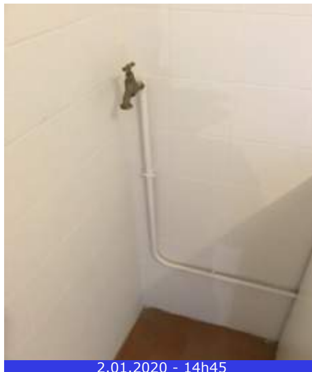
Photo 46 (Cuisine / arrivée d'eau / Bon état)
