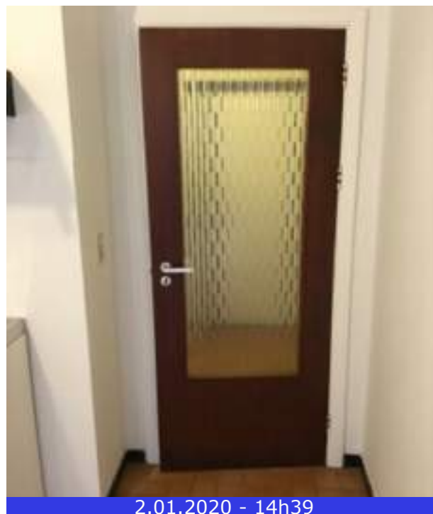
Photo 31 (Séjour / Porte(s) / Bon état)
