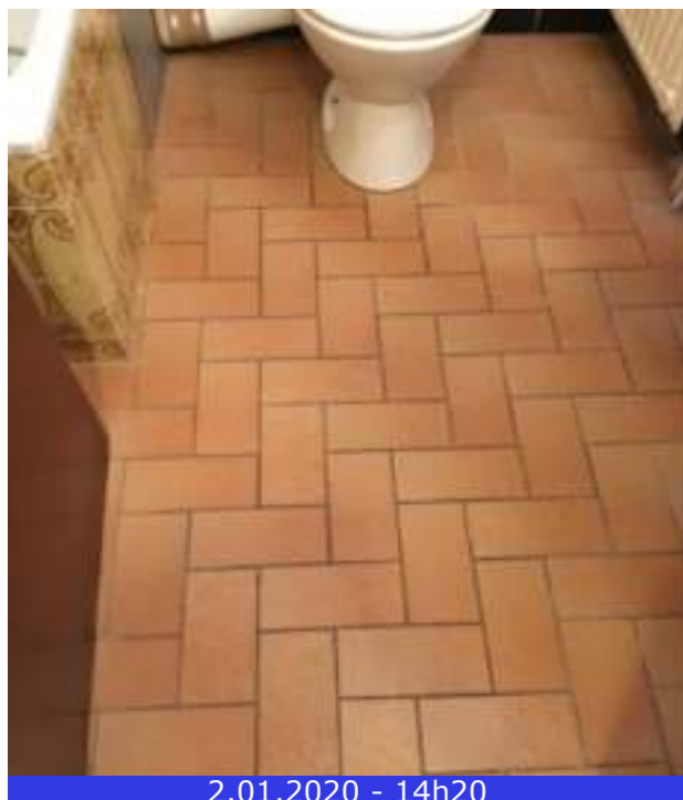
Photo 50 (Salle de bains / Sol / Bon état)
