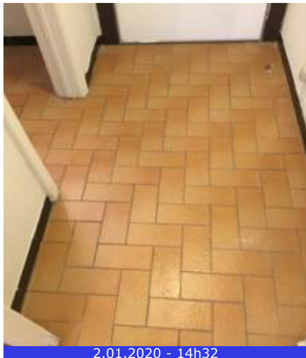
Photo 7 (Hall / Sol / Bon état)
