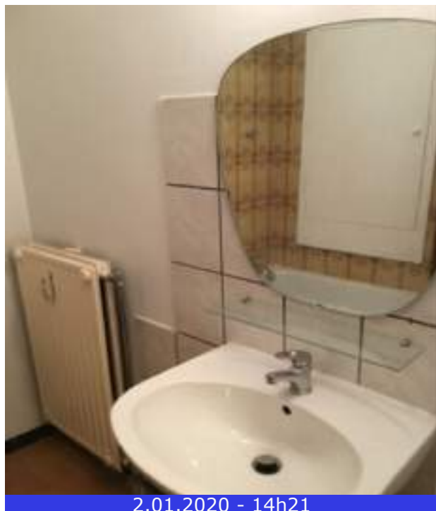
Photo 52 (Salle de bains / Murs / Bon état)
