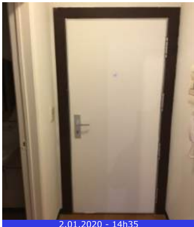
Photo 13 (Hall / Porte(s) / Bon état)
