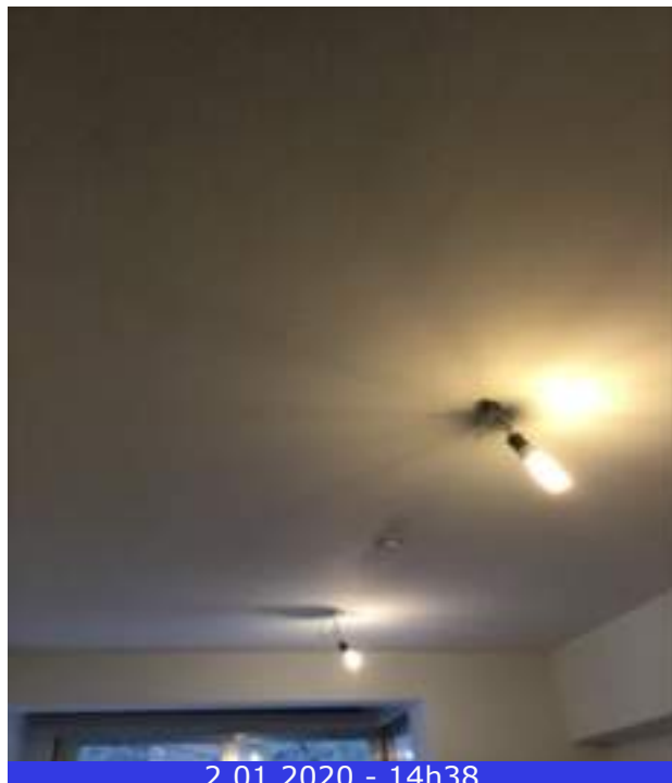
Photo 26 (Séjour / Plafond / Bon état)
