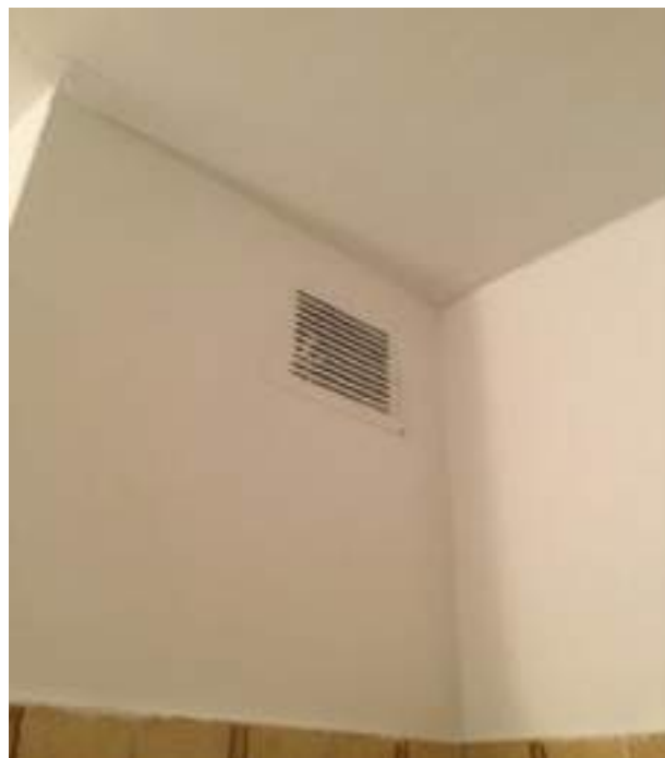
Photo 67 (Salle de bains / Ventilation / Bon état)
