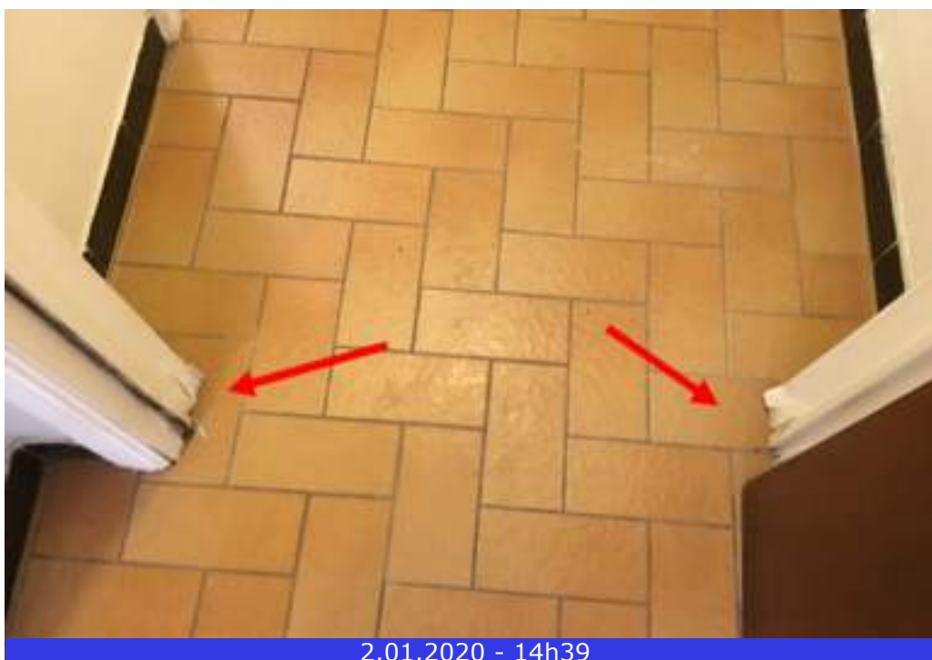
Photo 32 (Séjour / Porte(s) / Bon état)
