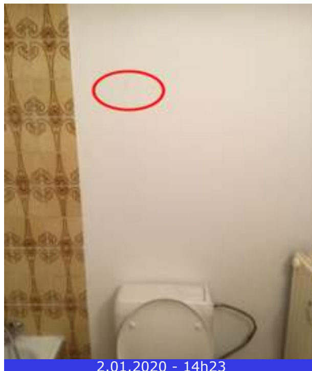
Photo 53 (Salle de bains / Murs / Bon état)
