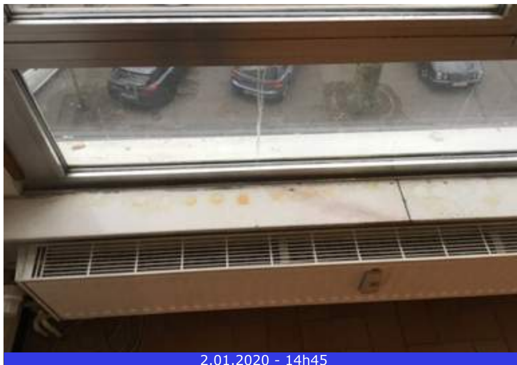
Photo 28 (Séjour / Fenêtre(s) / Bon état)
