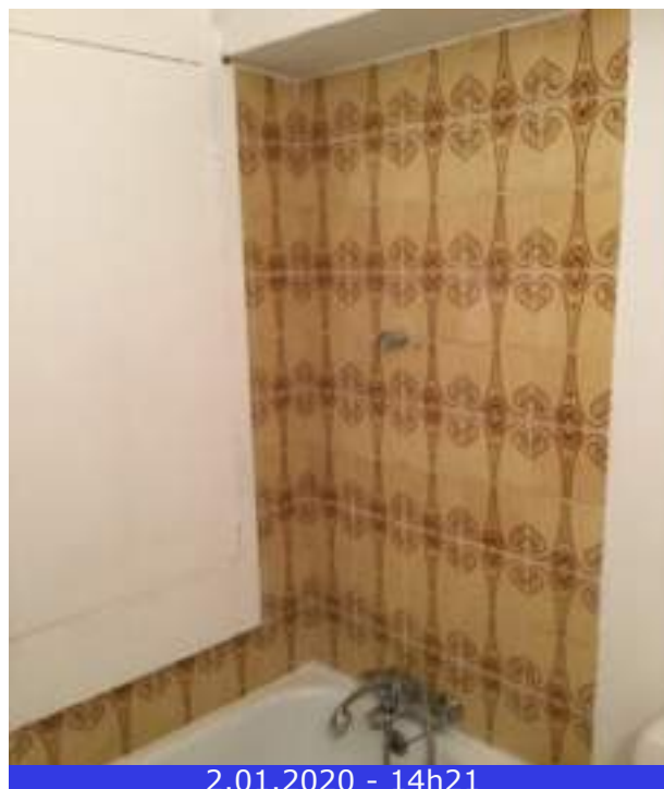
Photo 51 (Salle de bains / Murs / Bon état)
