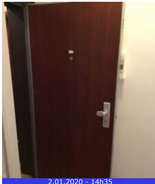
Photo 14 (Hall / Porte(s) / Bon état)
