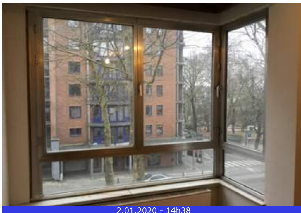
Photo 27 (Séjour / Fenêtre(s) / Bon état)
