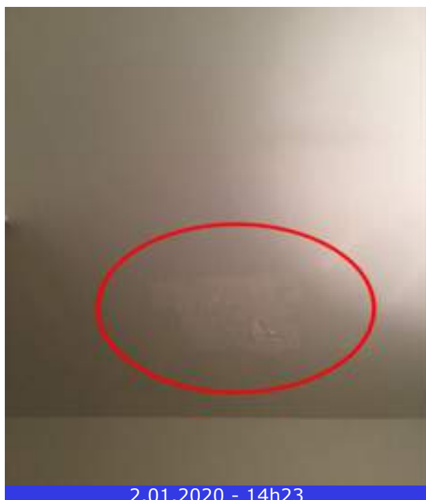
Photo 56 (Salle de bains / Plafond / Bon état)
