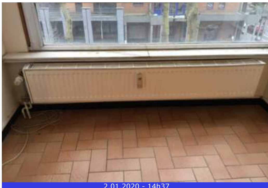
Photo 23 (Séjour / Radiateur(s) / Bon état)
