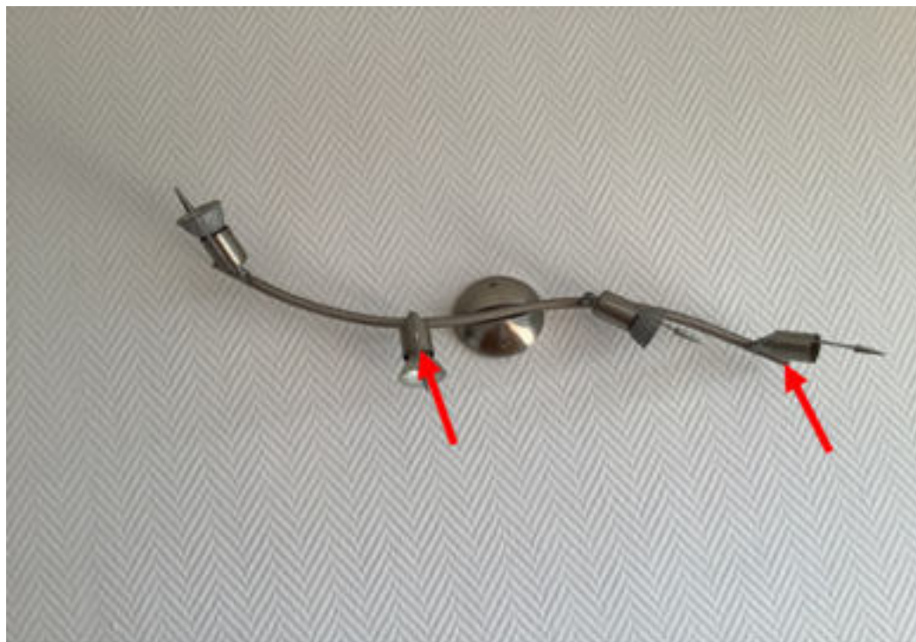
Photo 33 (Séjour / Point lumineux / Bon état)
