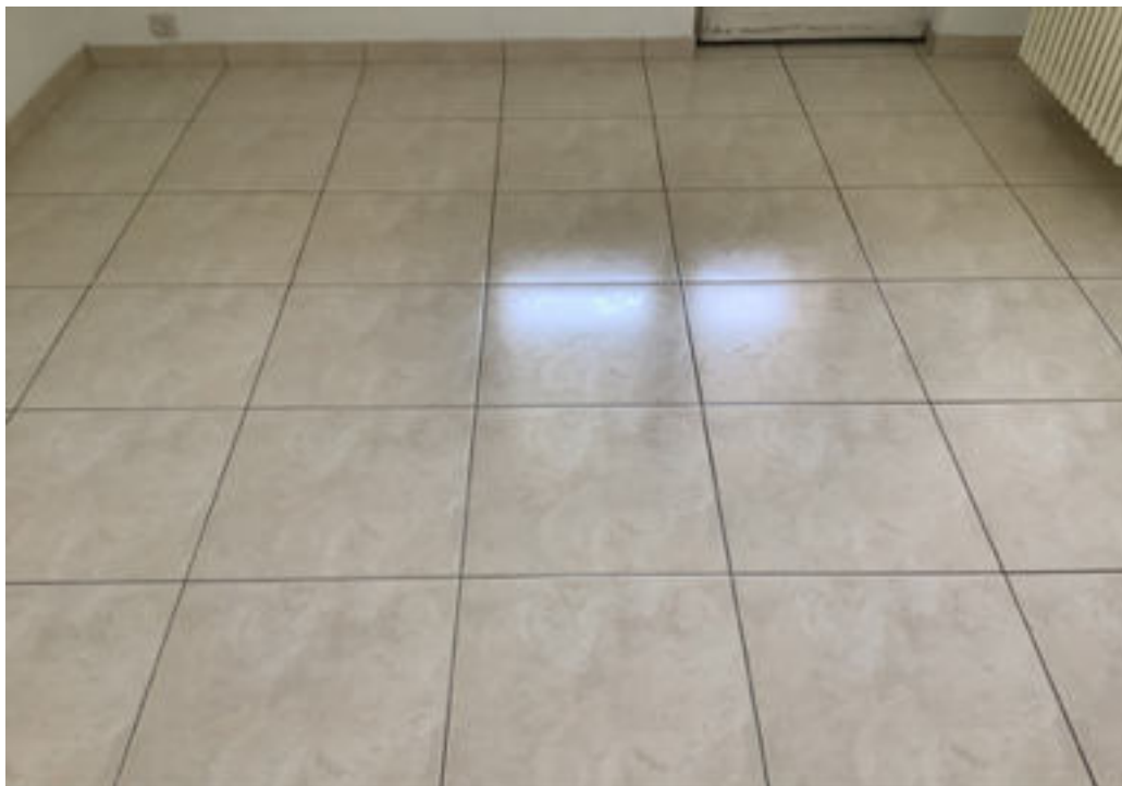
Photo 118 (Chambre avec balcon / Sol / Bon état)
