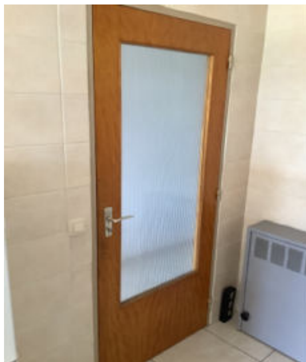
Photo 73 (Cuisine / Porte(s) / Bon état)
