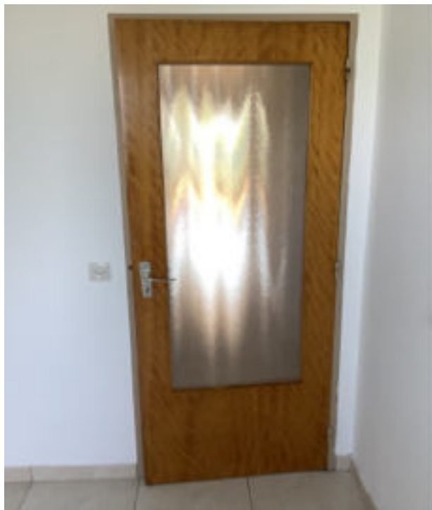
Photo 145 (Chambre 2 / Porte(s) / Bon état)
