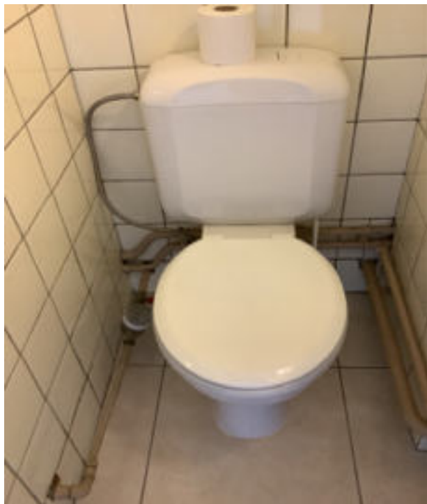
Photo 81 (WC / WC / Bon état)
