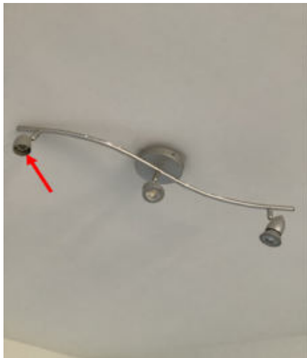
Photo 124 (Chambre avec balcon / Point lumineux / Bon état)
