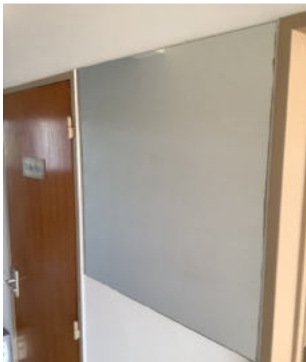
Photo 21 (Hall / miroir / Bon état)
