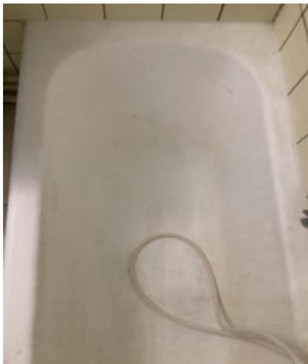
Photo 102 (Salle de bains / Baignoire / Etat d'usage)
