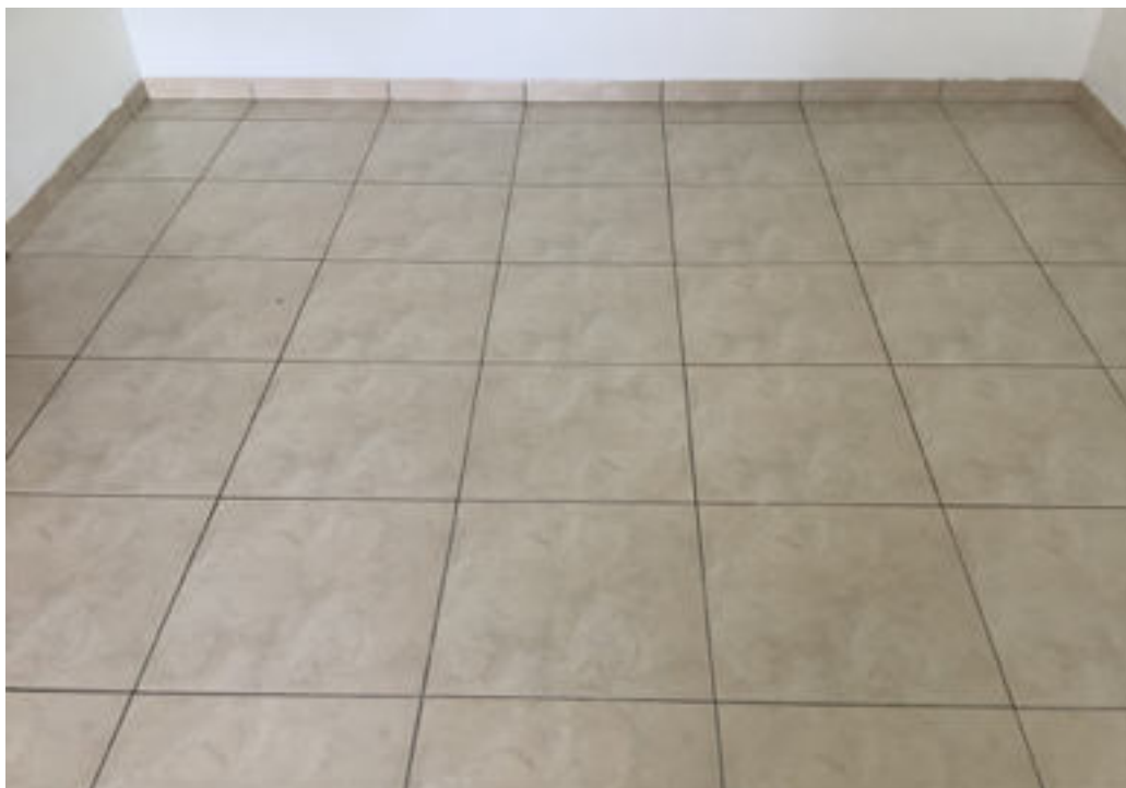
Photo 119 (Chambre avec balcon / Sol / Bon état)
