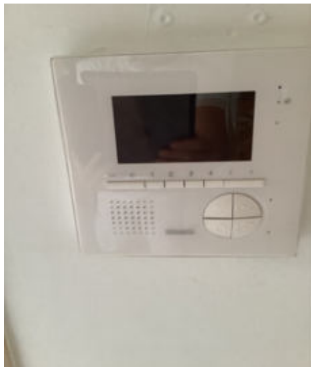
Photo 10 (Hall / Interphone / Bon état)
