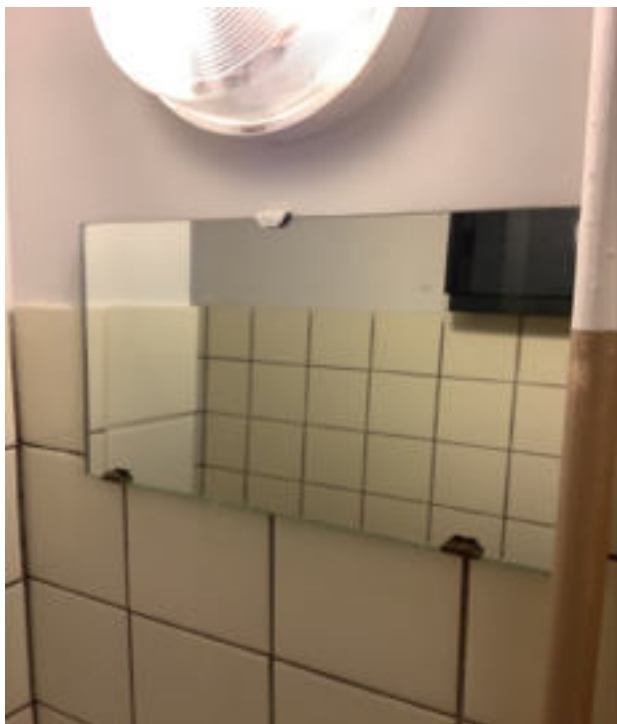
Photo 84 (WC / Accessoires / Bon état)
