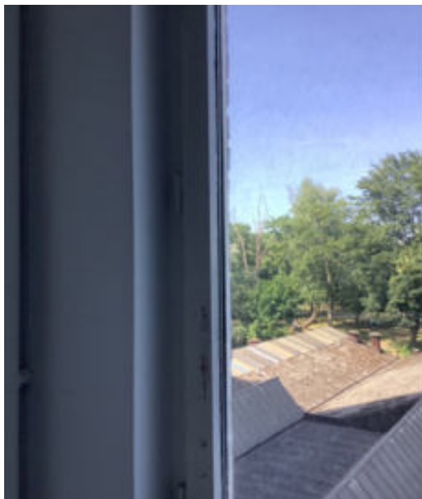
Photo 143 (Chambre 2 / Fenêtre(s) / Etat d'usage)
