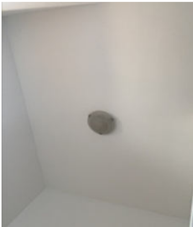
Photo 14 (Hall / Plafond / Bon état)
