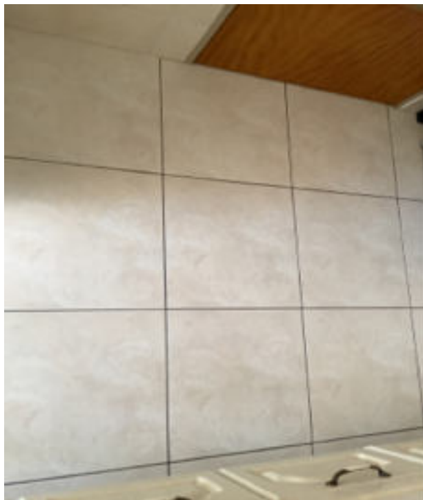
Photo 46 (Cuisine / Sol / Bon état)
