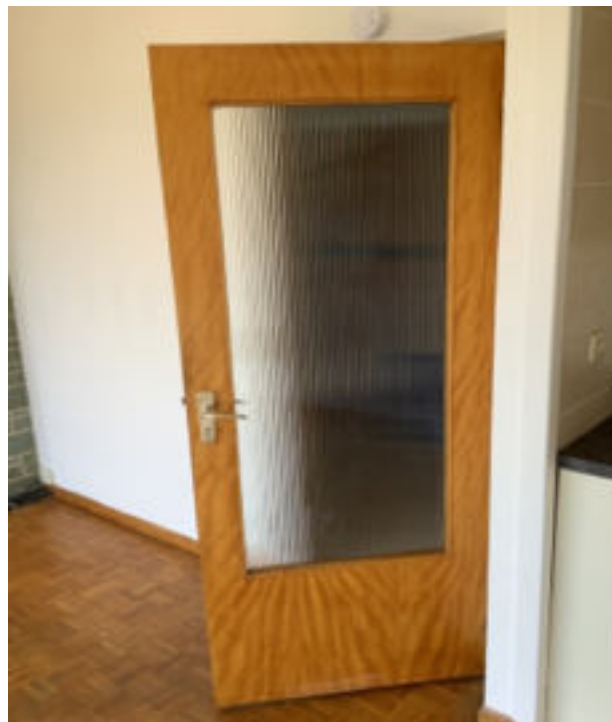
Photo 36 (Séjour / Porte(s) / Bon état)
