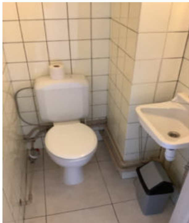
Photo 75 (Photo générale / WC)
