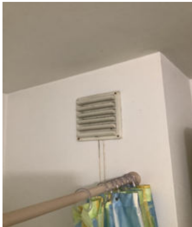
Photo 114 (Salle de bains / grille d'aération / Bon état)
