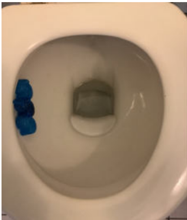
Photo 82 (WC / WC / Bon état)
