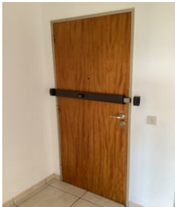
Photo 17 (Hall / Porte(s) / Bon état)
