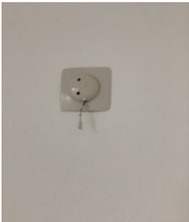
Photo 146 (Chambre 2 / Interrupteurs / prises / Bon état)
