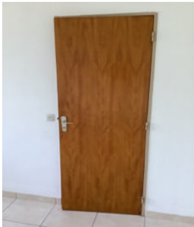
Photo 127 (Chambre avec balcon / Porte(s) / Bon état)
