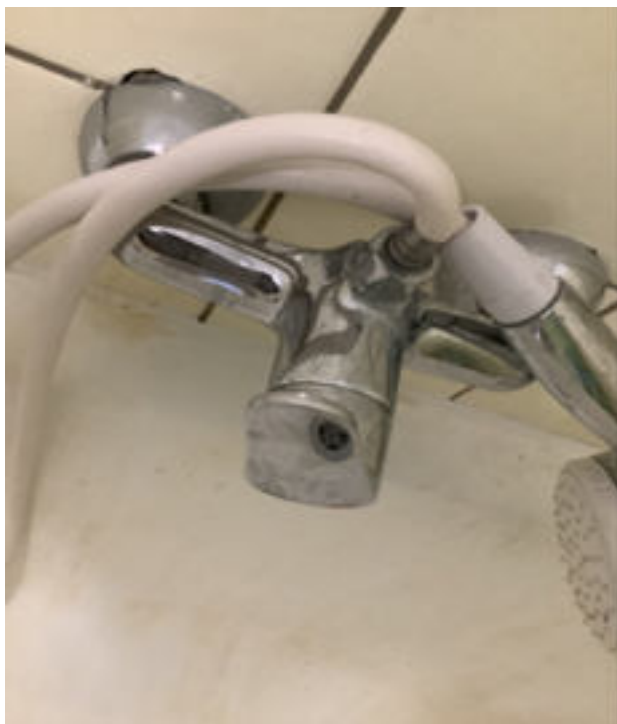
Photo 107 (Salle de bains / Robinetterie / Bon état)
