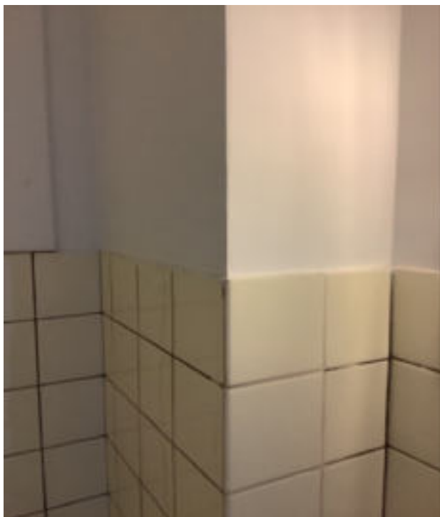
Photo 78 (WC / Murs / Bon état)
