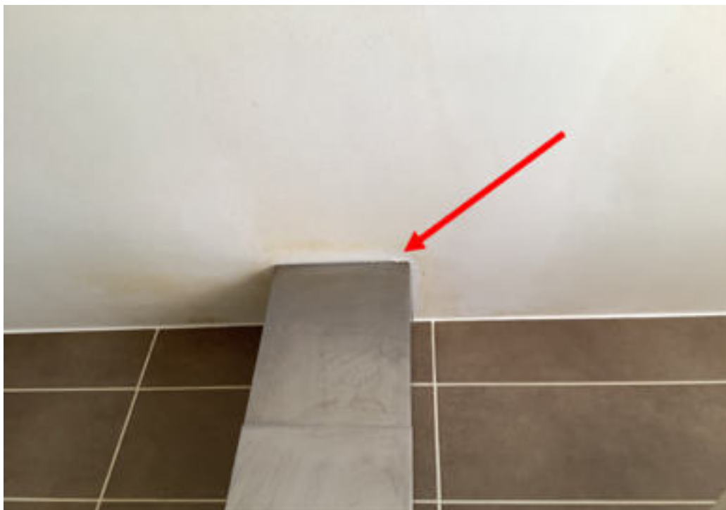
Photo 50 (Cuisine / Plafond / Bon état)
