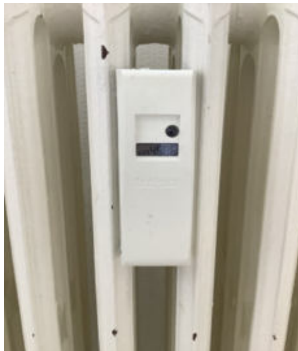
Photo 138 (Chambre 2 / Radiateur(s) / Bon état)
