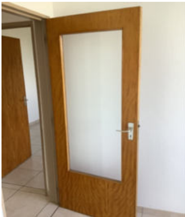
Photo 144 (Chambre 2 / Porte(s) / Bon état)
