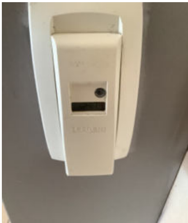
Photo 48 (Cuisine / Radiateur(s) / Bon état)
