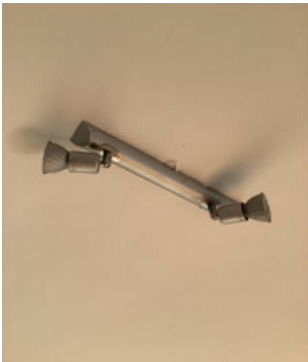
Photo 32 (Séjour / Point lumineux / Bon état)
