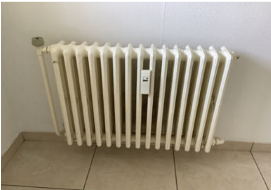
Photo 120 (Chambre avec balcon / Radiateur(s) / Bon état)
