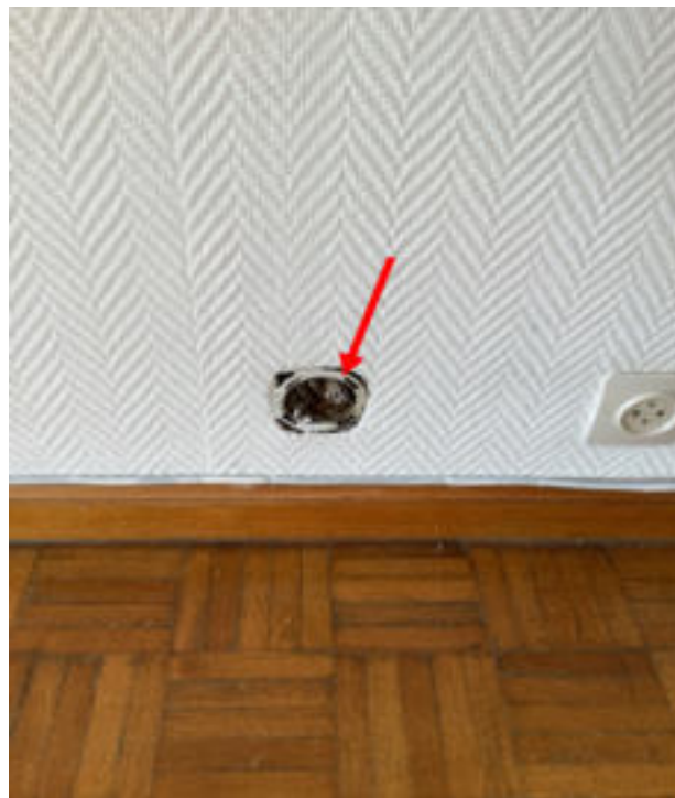
Photo 40 (Séjour / Interrupteurs / prises / Bon état)
