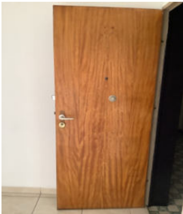
Photo 18 (Hall / Porte(s) / Bon état)
