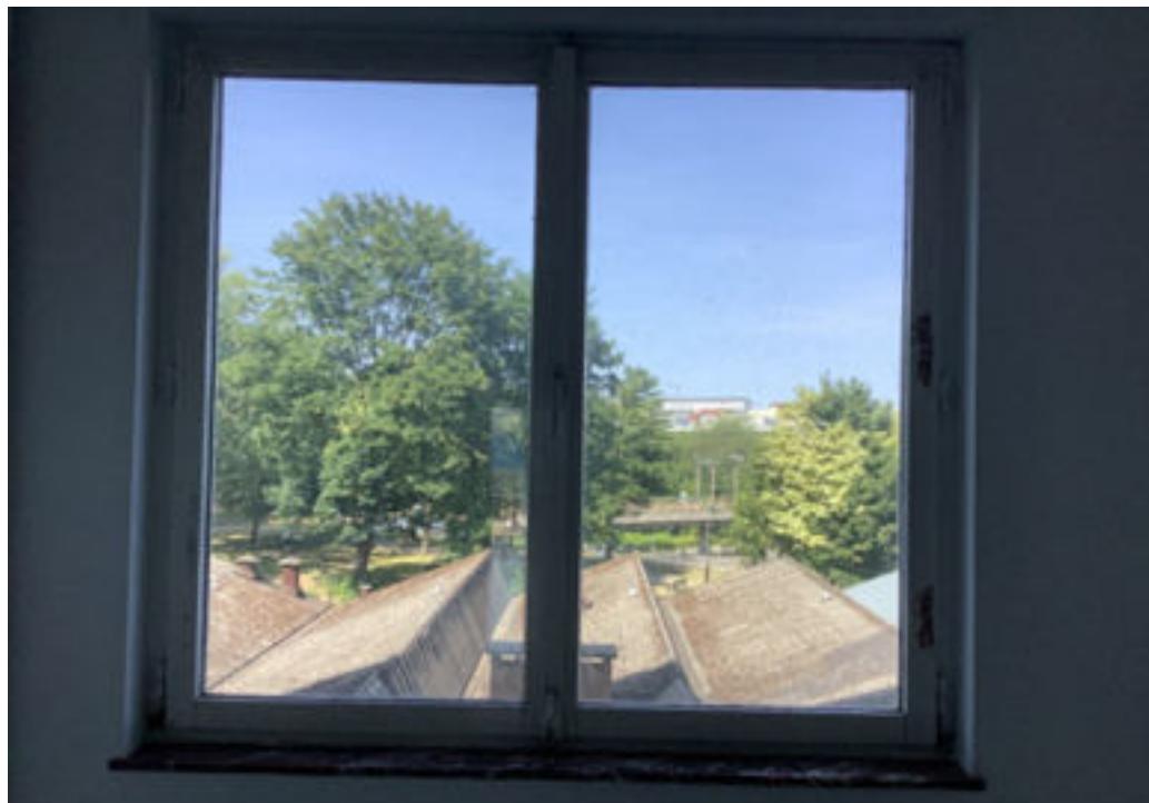
Photo 141 (Chambre 2 / Fenêtre(s) / Etat d'usage)
