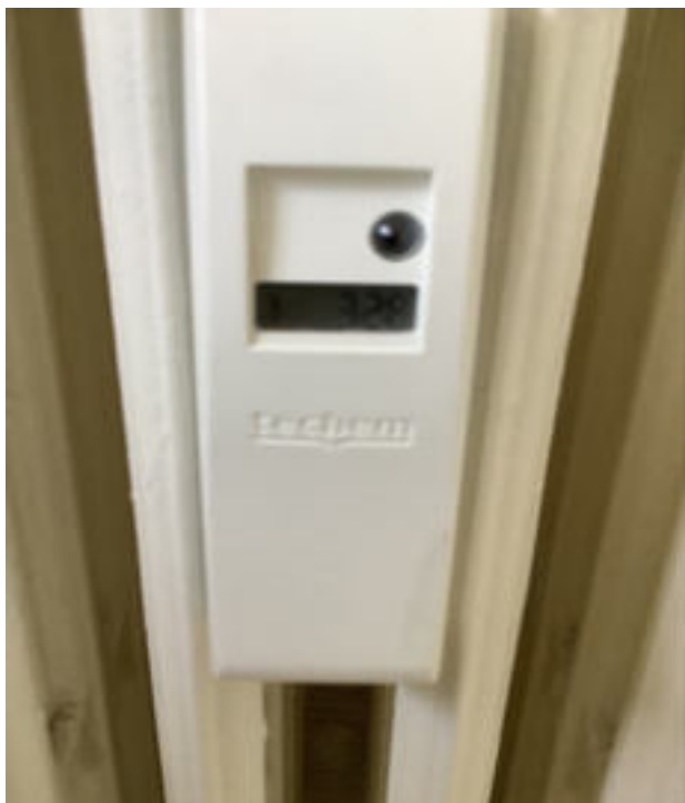
Photo 121 (Chambre avec balcon / Radiateur(s) / Bon état)
