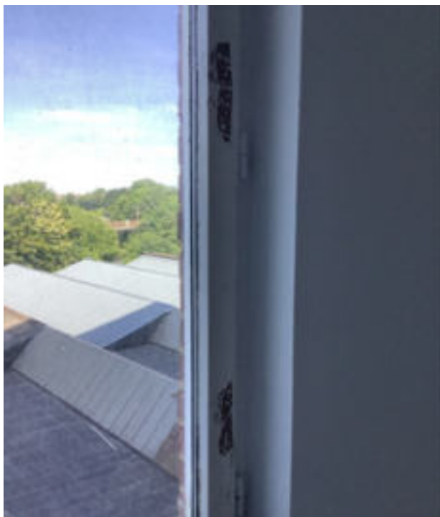
Photo 142 (Chambre 2 / Fenêtre(s) / Etat d'usage)
