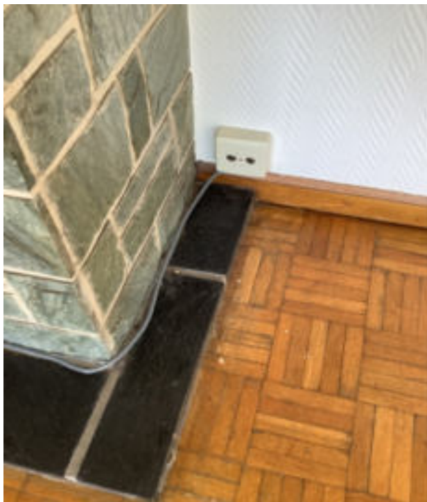
Photo 39 (Séjour / Interrupteurs / prises / Bon état)
