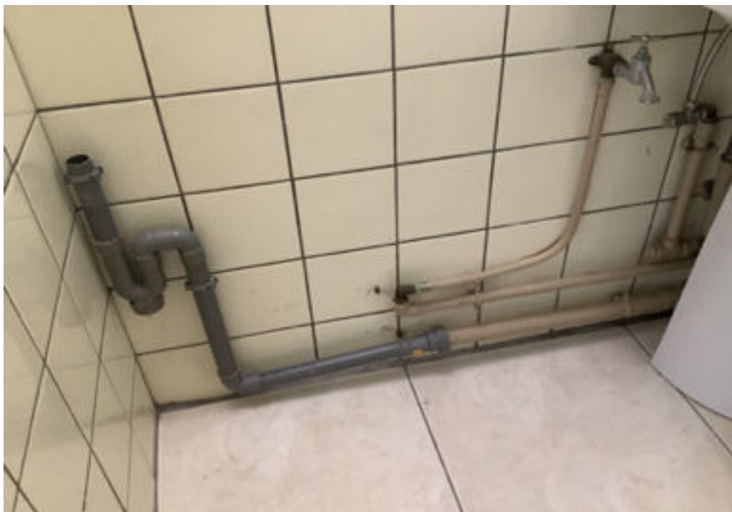
Photo 112 (Salle de bains / arrivée + évacuation d'eau / Bon état)
