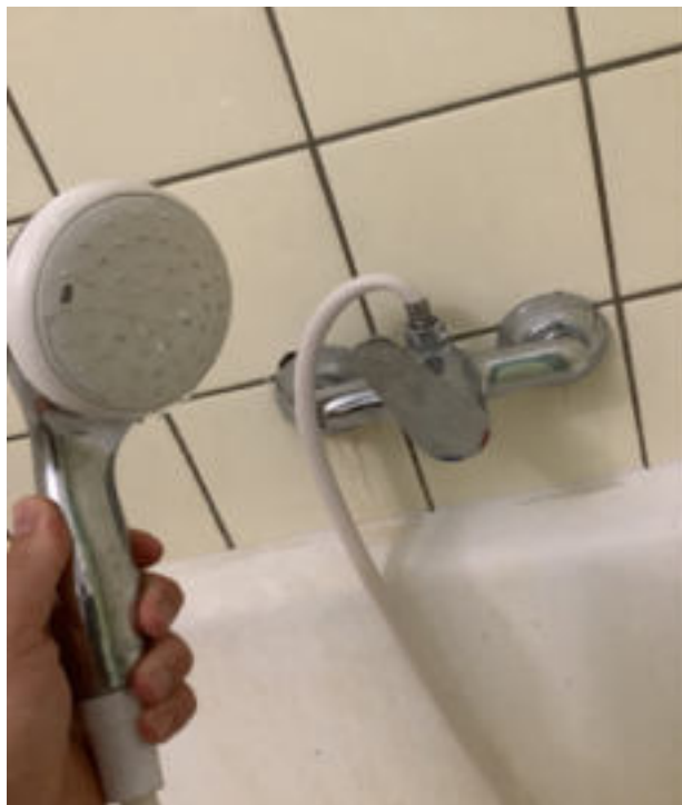
Photo 104 (Salle de bains / Baignoire / Etat d'usage)
