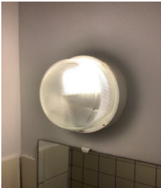
Photo 80 (WC / Point lumineux / Bon état)
