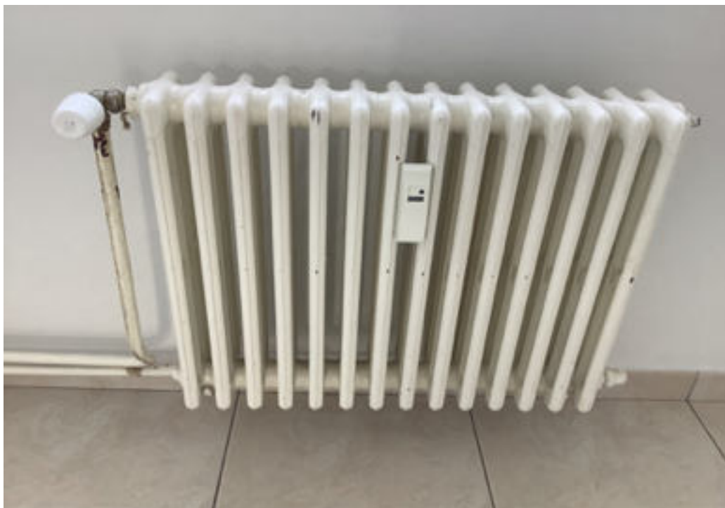
Photo 136 (Chambre 2 / Radiateur(s) / Bon état)
