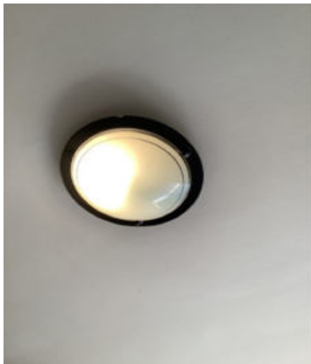
Photo 51 (Cuisine / Point lumineux / Bon état)
