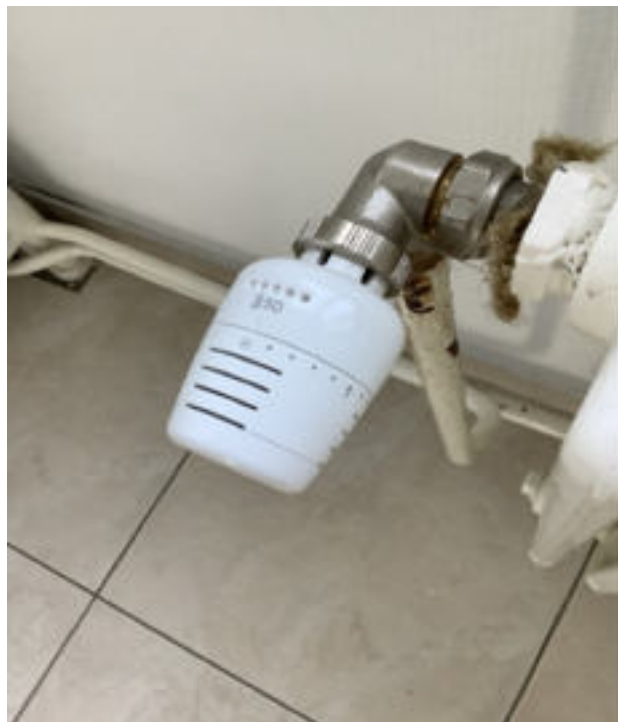
Photo 137 (Chambre 2 / Radiateur(s) / Bon état)
