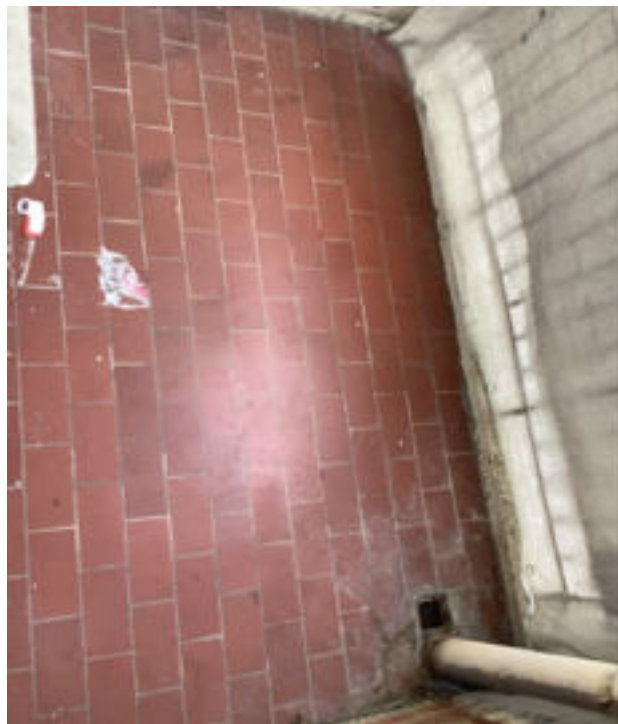
Photo 130 (Chambre avec balcon / balcon / Bon état)
