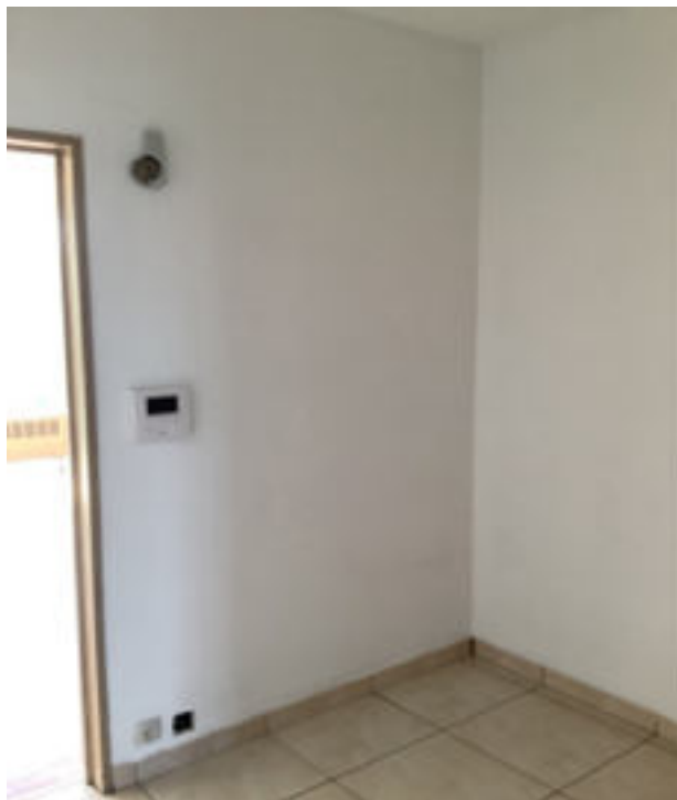
Photo 6 (Photo générale / Hall)
