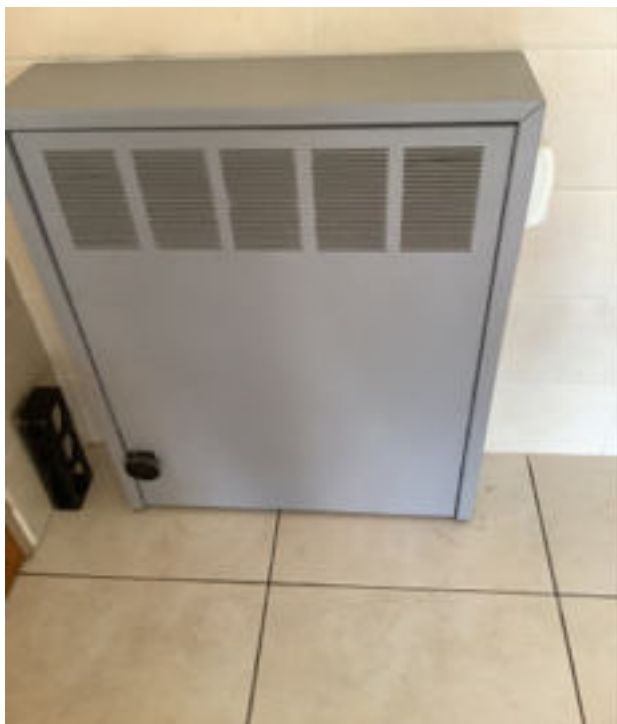
Photo 47 (Cuisine / Radiateur(s) / Bon état)
