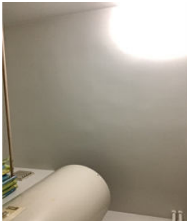
Photo 100 (Salle de bains / Plafond / Bon état)
