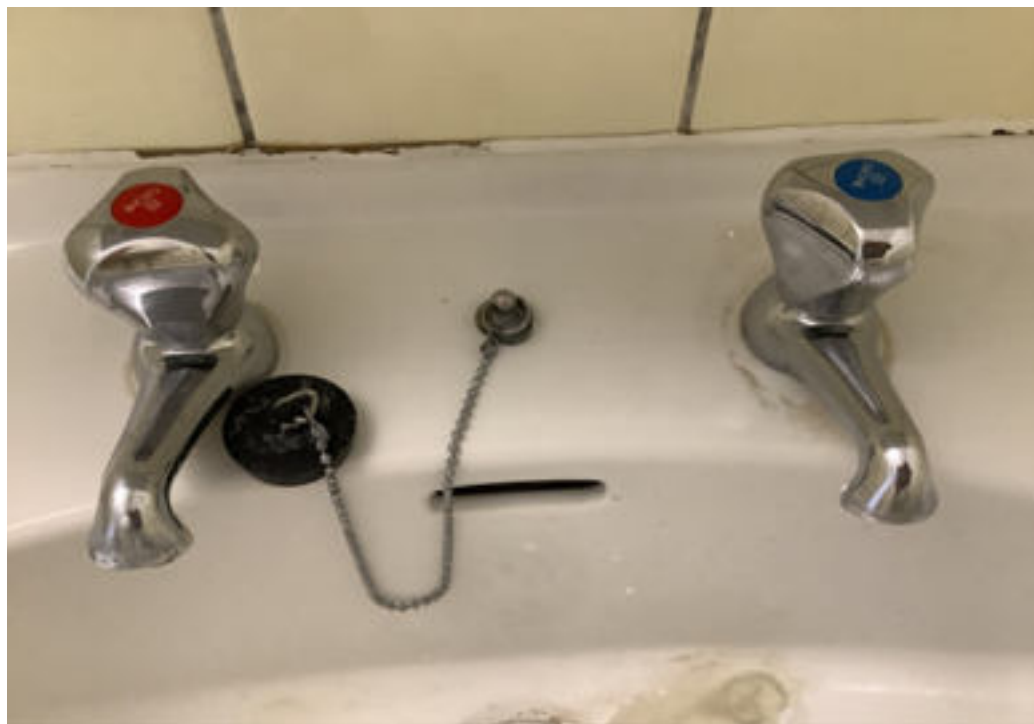
Photo 108 (Salle de bains / Robinetterie / Bon état)
