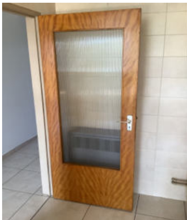
Photo 72 (Cuisine / Porte(s) / Bon état)
