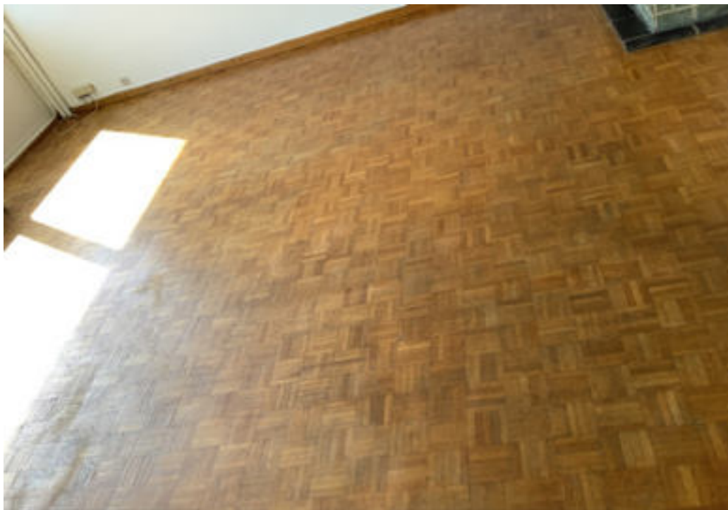
Photo 26 (Séjour / Sol / Etat d'usage)
