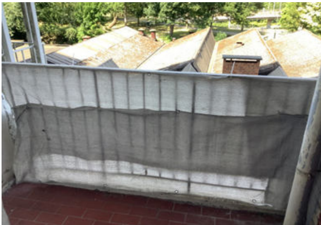
Photo 129 (Chambre avec balcon / balcon / Bon état)
