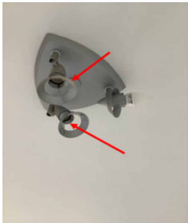
Photo 140 (Chambre 2 / Point lumineux / Bon état)
