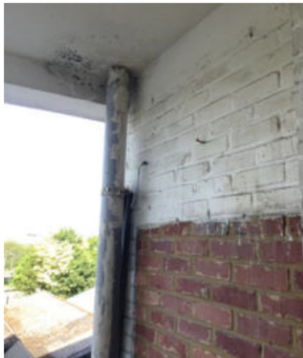
Photo 131 (Chambre avec balcon / balcon / Bon état)
