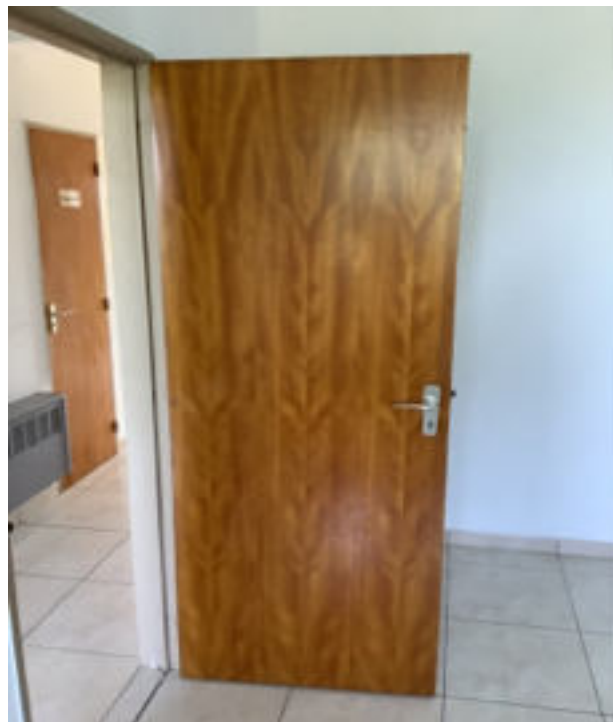
Photo 128 (Chambre avec balcon / Porte(s) / Bon état)
