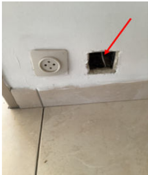
Photo 19 (Hall / Interrupteurs / prises / Bon état)
