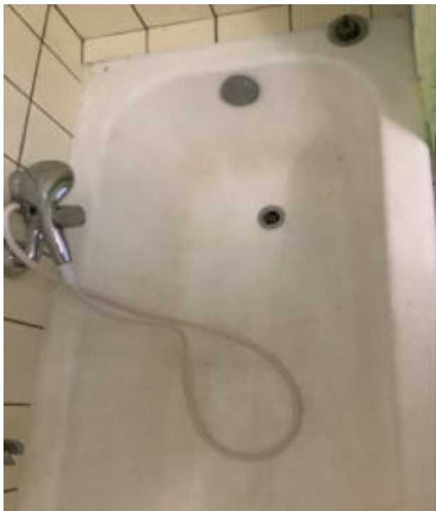
Photo 103 (Salle de bains / Baignoire / Etat d'usage)
