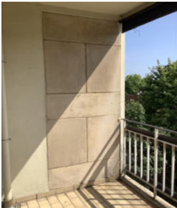
Photo 148 (Photo générale / Terrasse)
