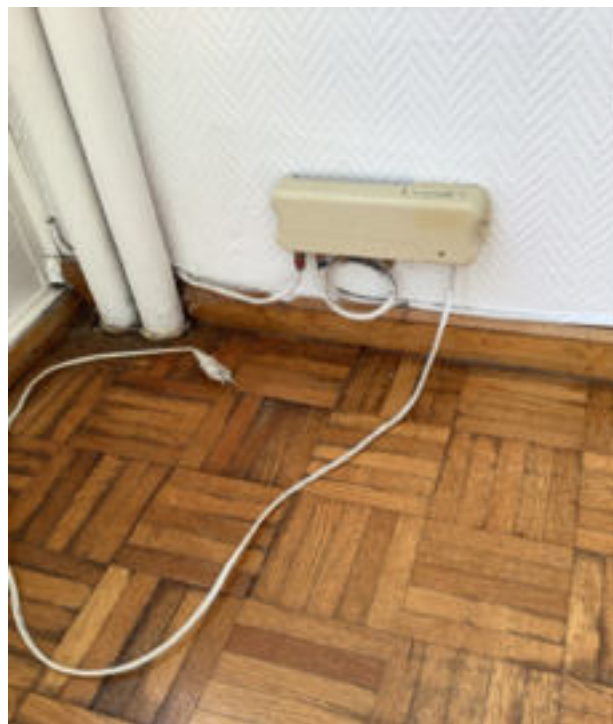
Photo 38 (Séjour / Interrupteurs / prises / Bon état)
