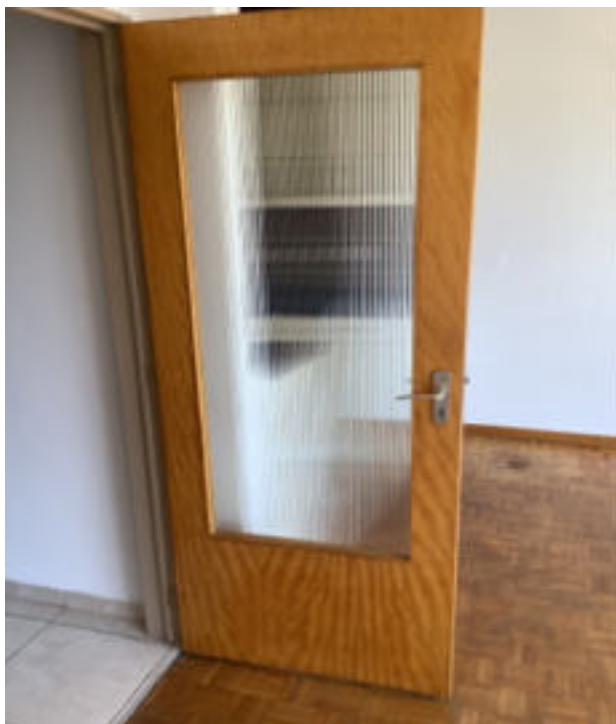
Photo 37 (Séjour / Porte(s) / Bon état)
