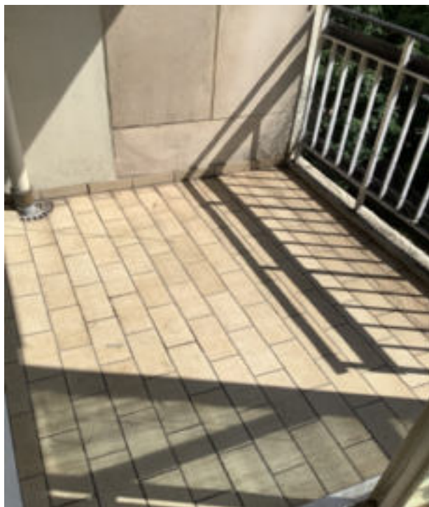
Photo 147 (Photo générale / Terrasse)
