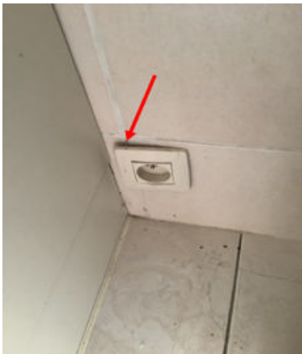
Photo 74 (Cuisine / Interrupteurs / prises / Bon état)
