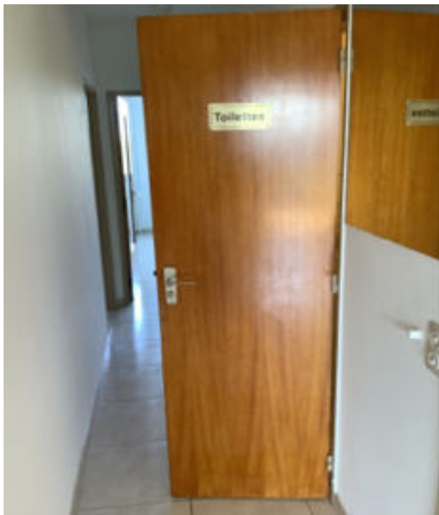
Photo 86 (WC / Porte(s) / Bon état)
