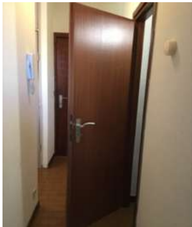
Photo 84 (WC / Porte(s) / Bon état)
