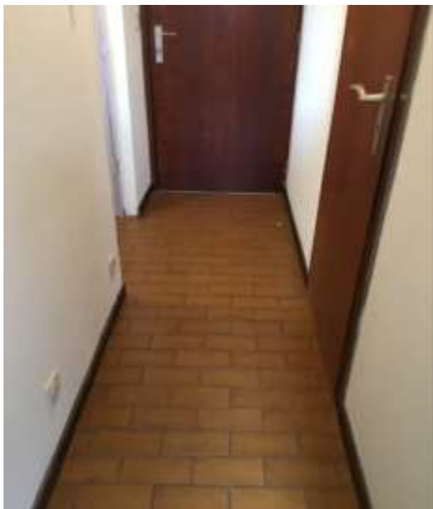
Photo 13 (Photo générale / Hall d'entrée )
