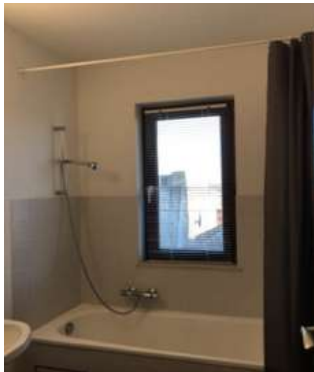
Photo 90 (Photo générale / Salle de bains)
