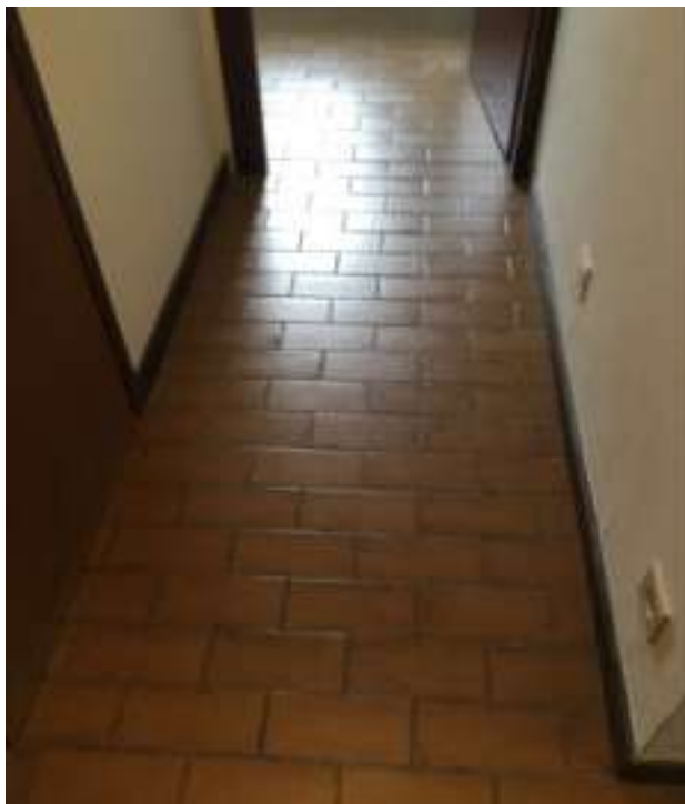
Photo 15 (Photo générale / Hall d'entrée )
