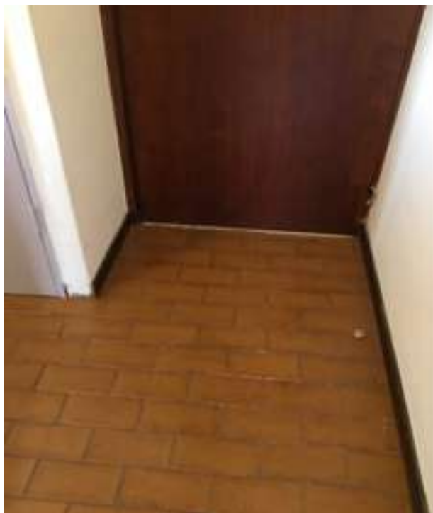
Photo 14 (Photo générale / Hall d'entrée )
