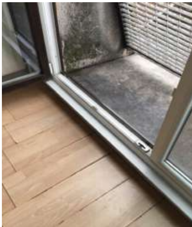
Photo 68 (Séjour / Seuil / Bon état)
