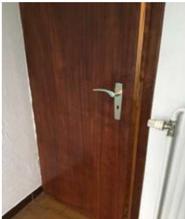
Photo 113 (Salle de bains / Porte(s) / Etat d'usage)
