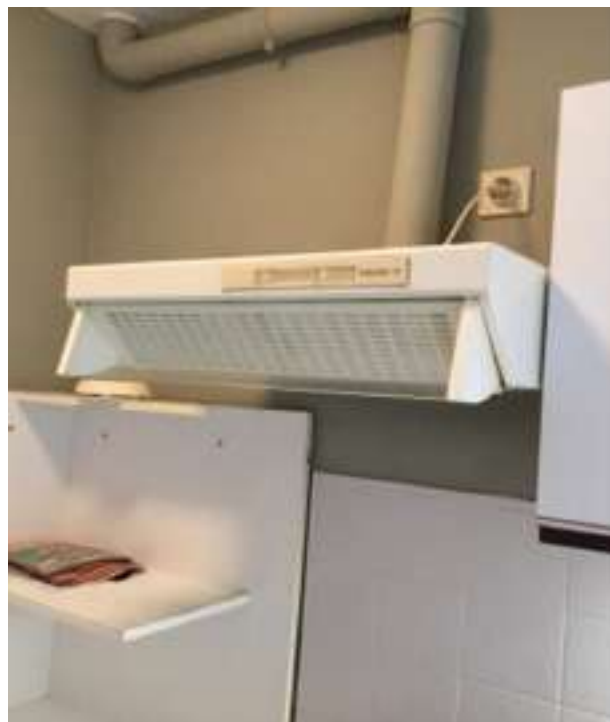
Photo 56 (Cuisine / Hotte aspirante / Etat d'usage)
