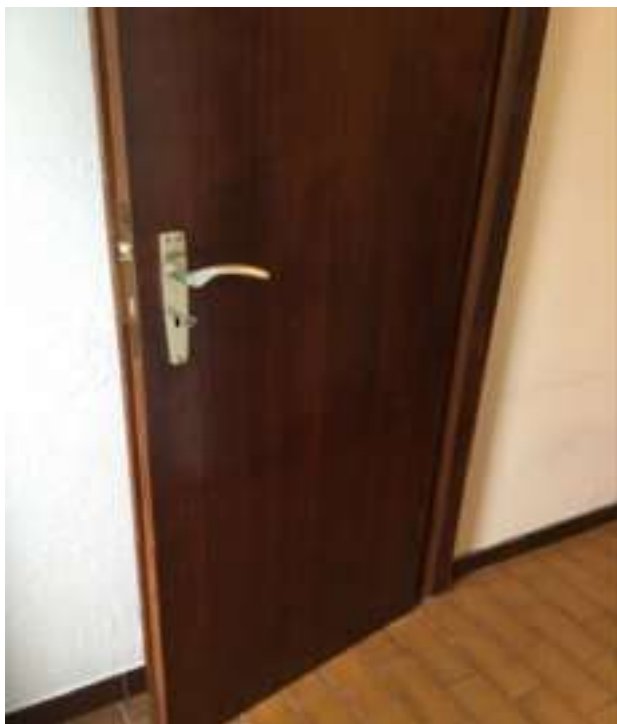
Photo 112 (Salle de bains / Porte(s) / Etat d'usage)
