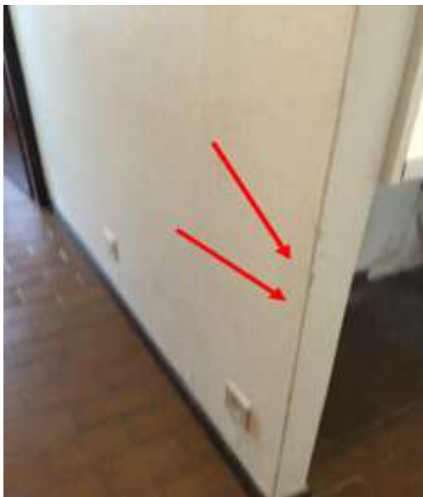
Photo 21 (Hall d'entrée / Murs / Etat d'usage)
