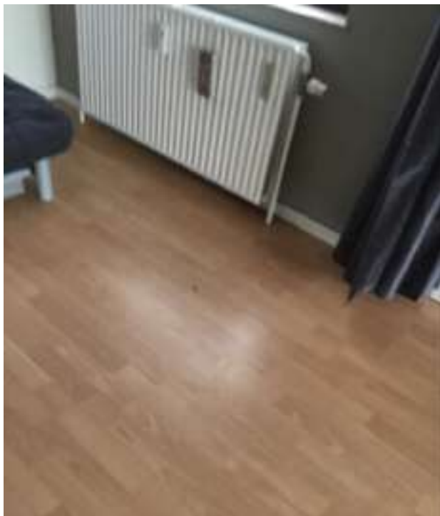
Photo 121 (Coin chambre / Murs / Etat d'usage)
