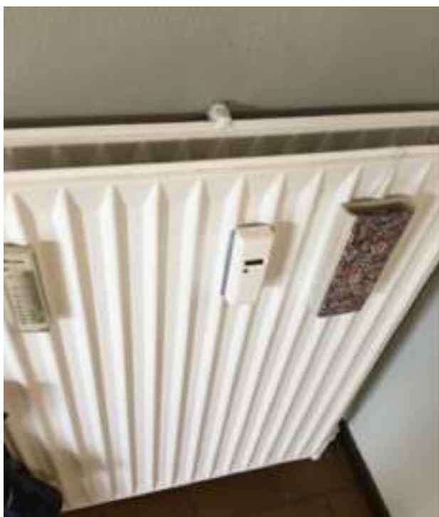
Photo 45 (Cuisine / Radiateur(s) / Etat d'usage)
