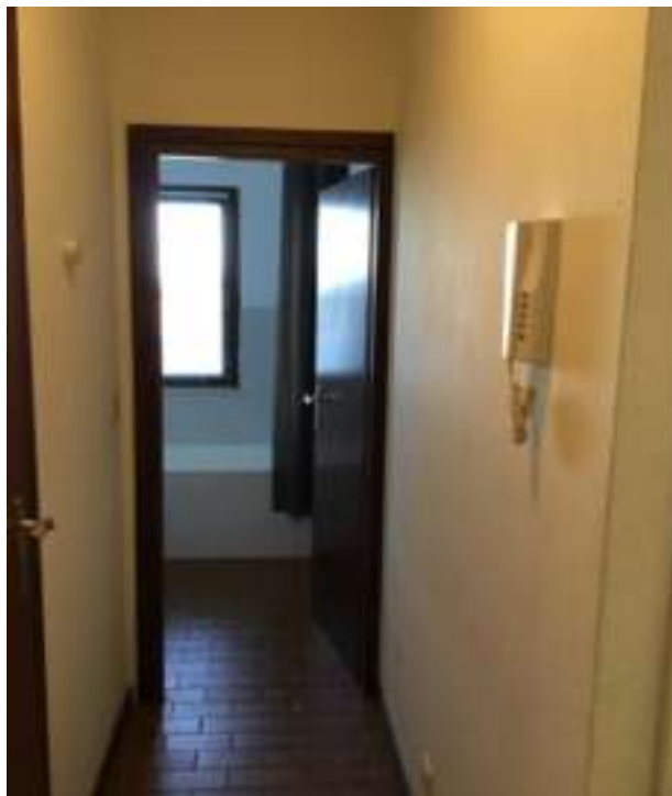
Photo 20 (Hall d'entrée / Murs / Etat d'usage)
