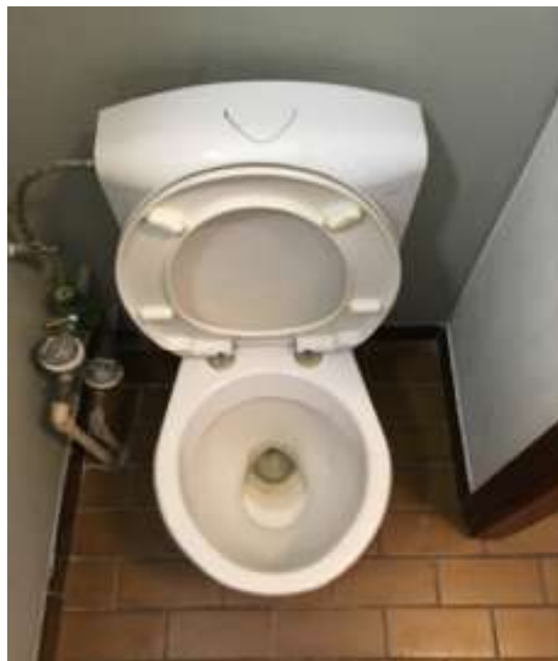
Photo 82 (WC / WC / Bon état)
