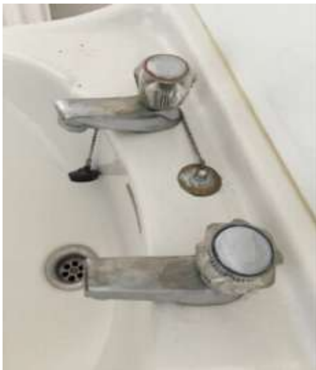
Photo 108 (Salle de bains / Robinetterie / Etat d'usage)
