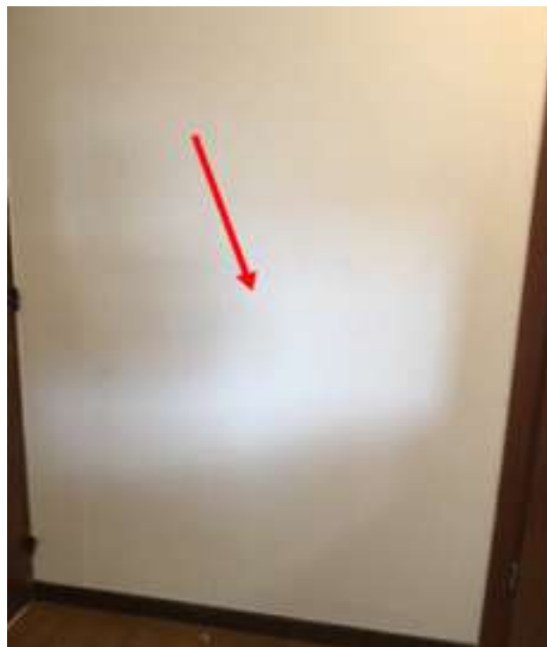
Photo 22 (Hall d'entrée / Murs / Etat d'usage)
