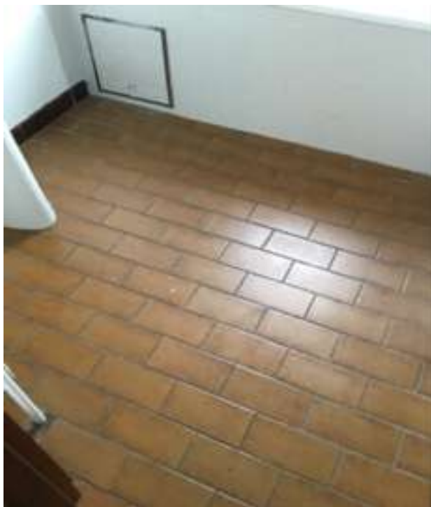
Photo 93 (Salle de bains / Sol / Etat d'usage)
