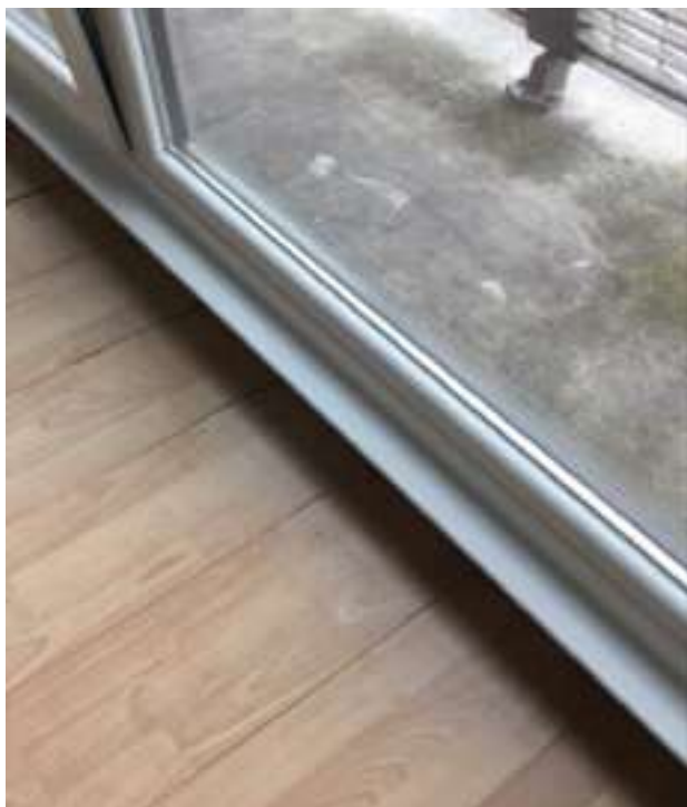
Photo 67 (Séjour / Seuil / Bon état)
