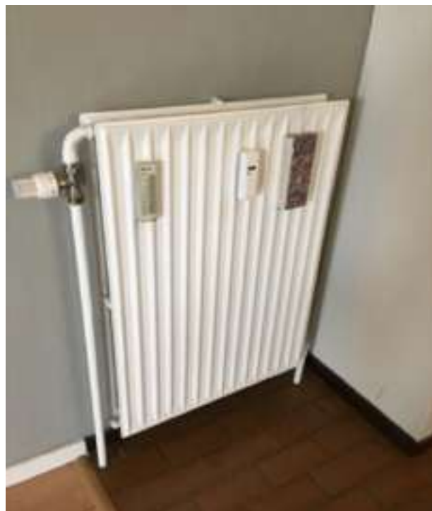
Photo 44 (Cuisine / Radiateur(s) / Etat d'usage)
