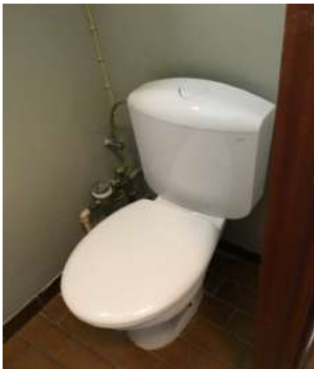
Photo 81 (WC / WC / Bon état)
