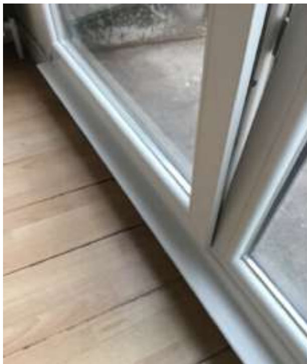
Photo 66 (Séjour / Seuil / Bon état)
