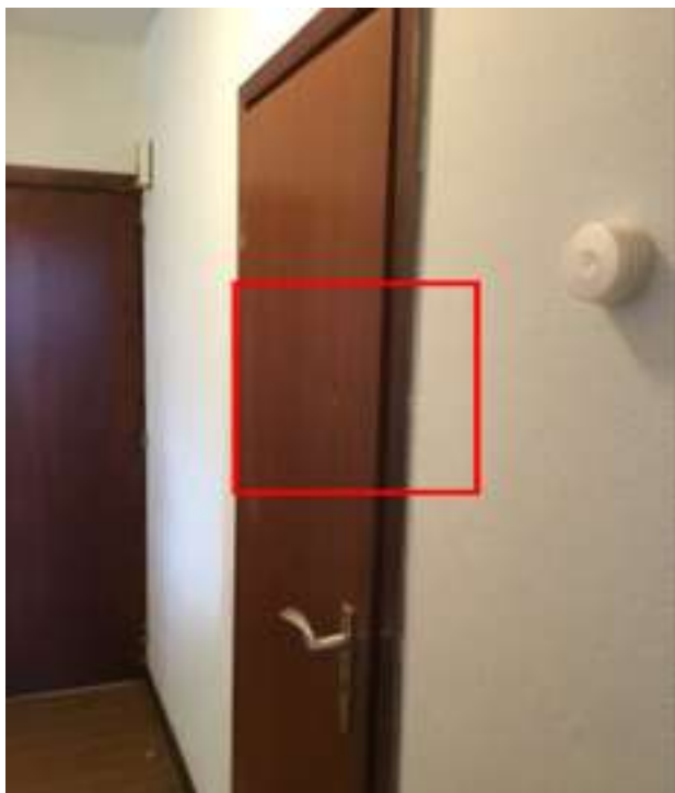
Photo 83 (WC / Porte(s) / Bon état)
