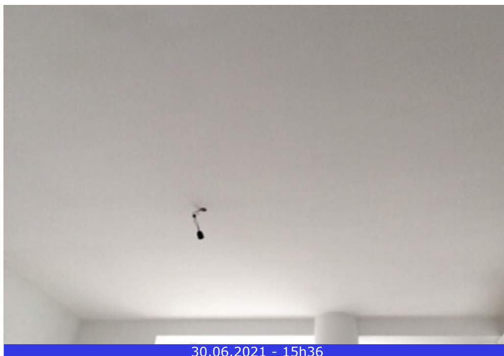
Photo 54 (Séjour / Plafond / Bon état)
