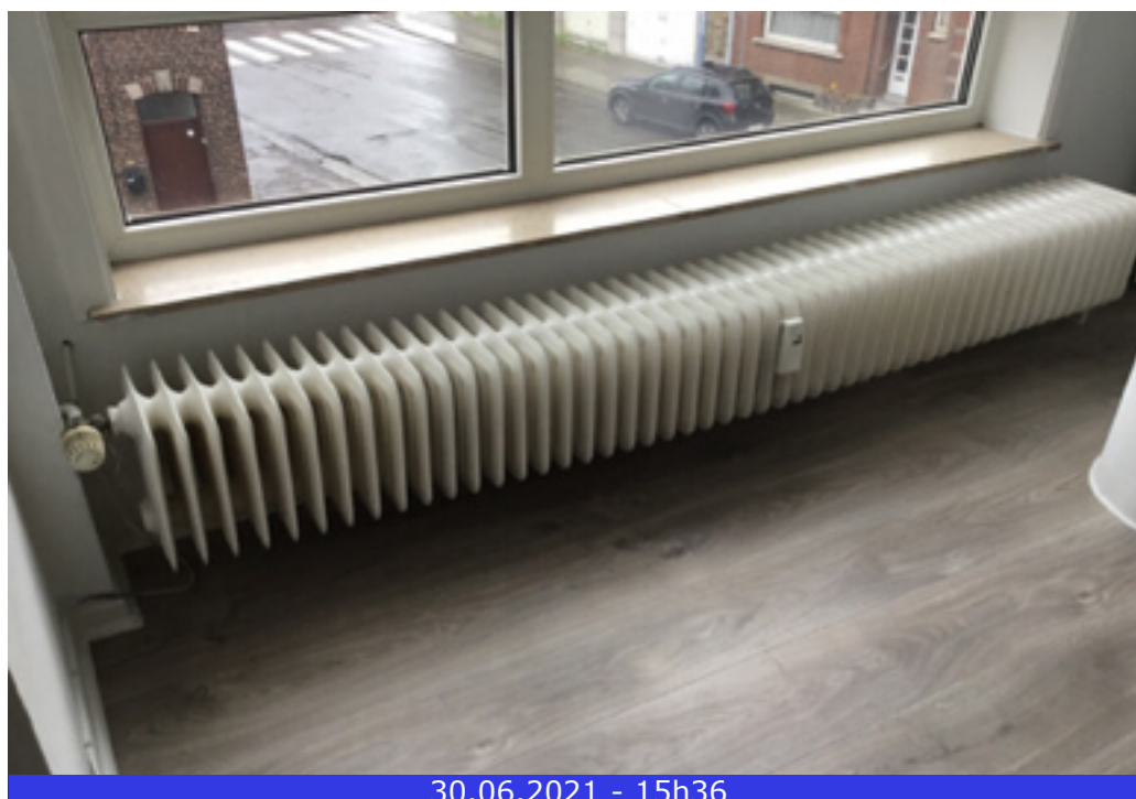
Photo 51 (Séjour / Radiateur(s) / Bon état)
