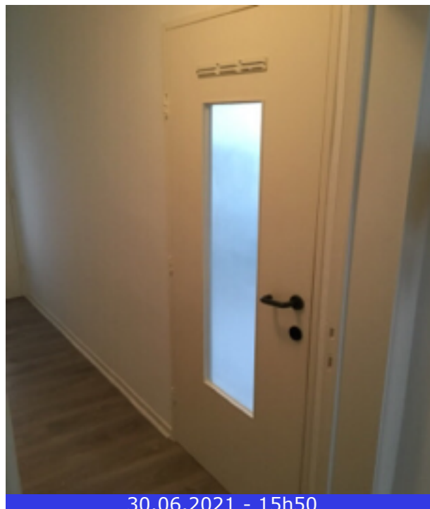
Photo 95 (Chambre / Porte(s) / Bon état)
