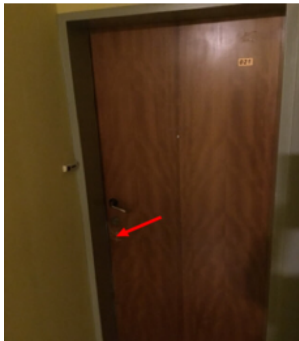
Photo 14 (Hall / Porte(s) / Bon état)
