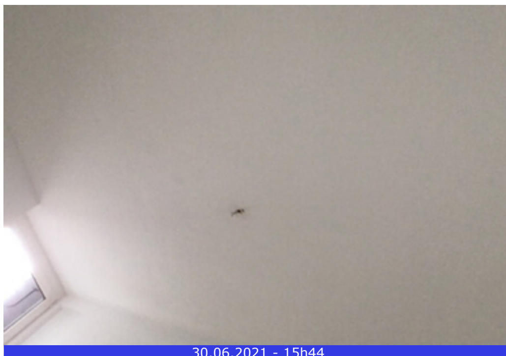
Photo 91 (Chambre / Plafond / Bon état)
