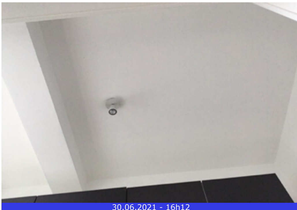
Photo 62 (Cuisine / Plafond / Bon état)
