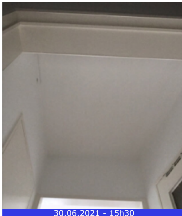
Photo 12 (Hall / Plafond / Bon état)
