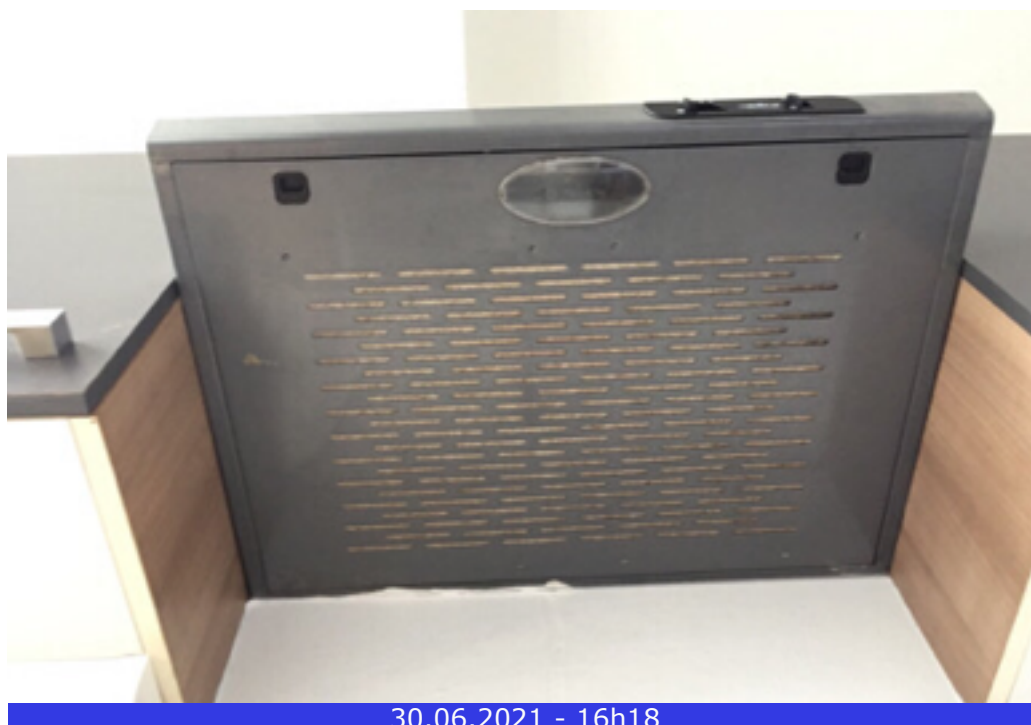
Photo 76 (Cuisine / Hotte aspirante / Bon état)
