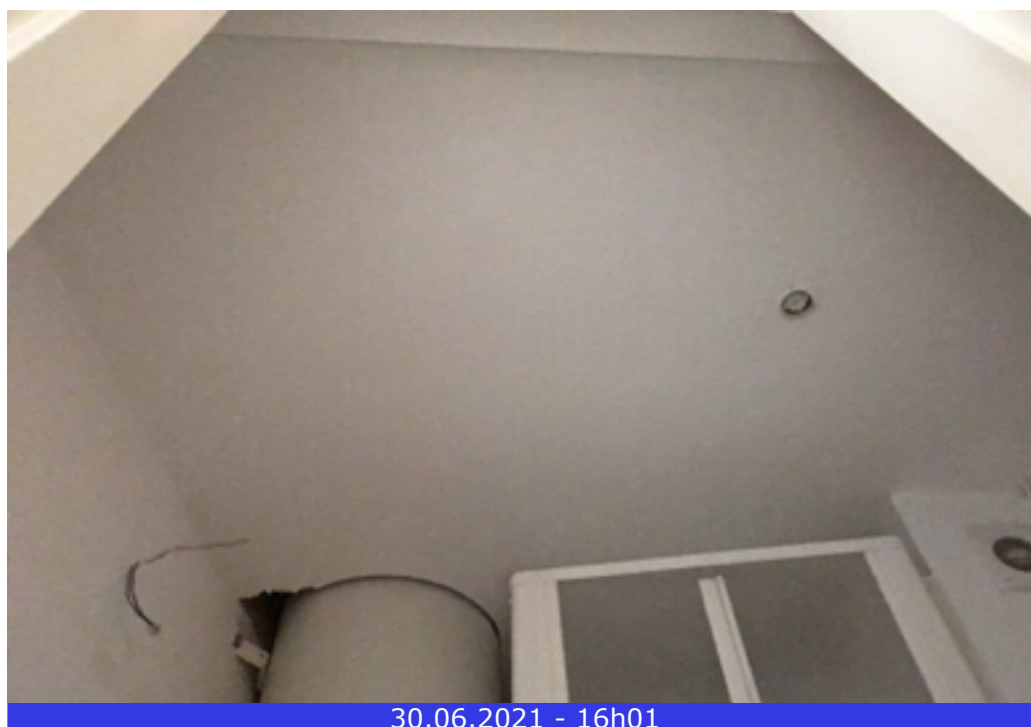
Photo 24 (Salle de bains / Plafond / Bon état)
