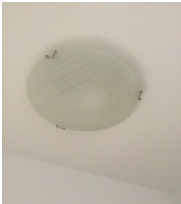
Photo 13 (Hall / Point lumineux / Bon état)
