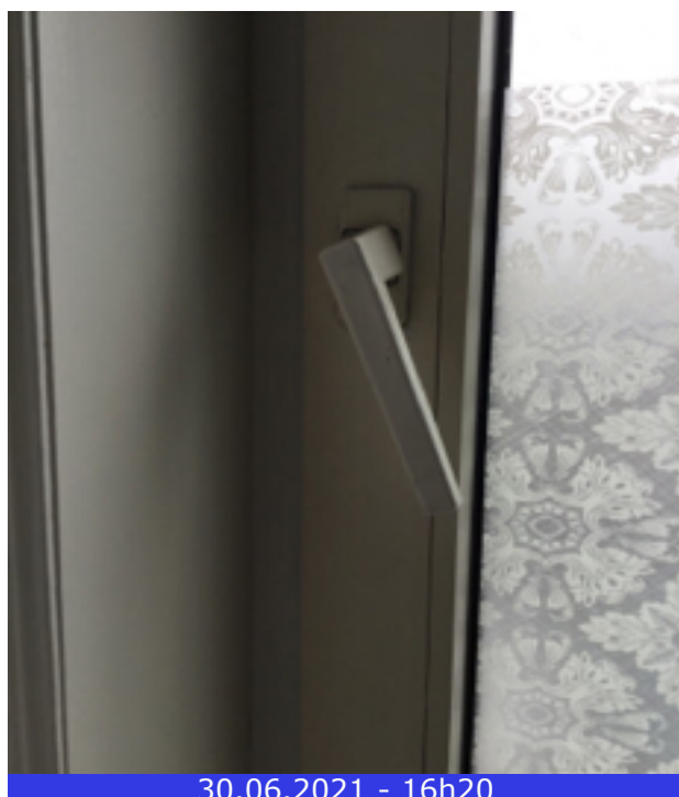
Photo 81 (Cuisine / Fenêtre(s) / Bon état)
