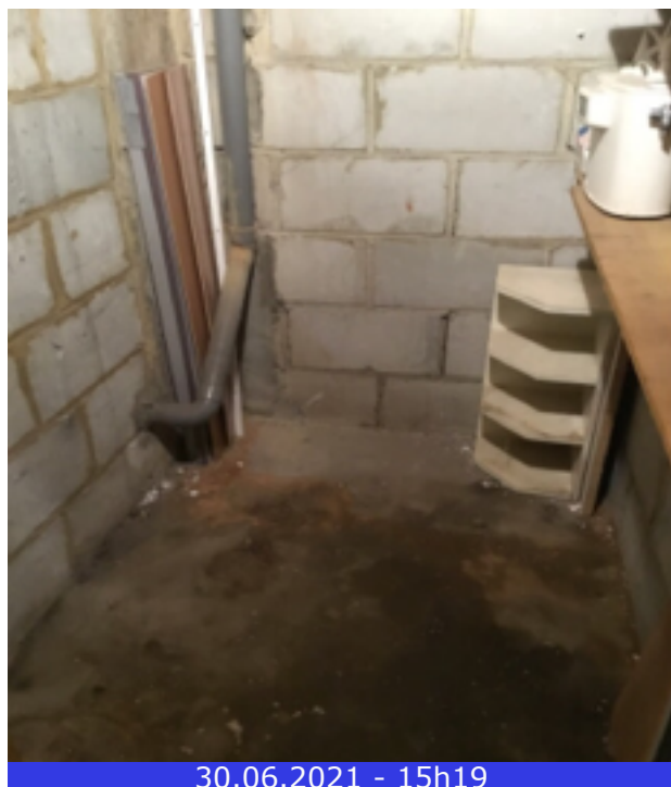
Photo 108 (Photo générale / Cave)
