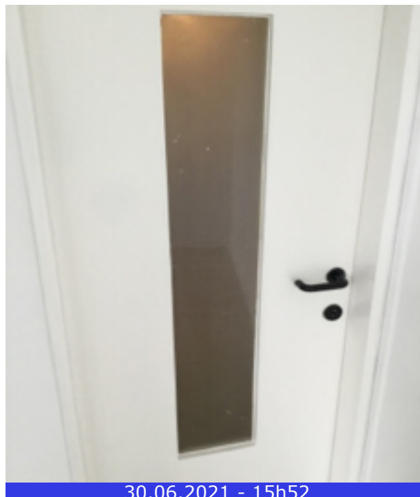
Photo 107 (Chambre (de derrière) / Porte(s) / Bon état)
