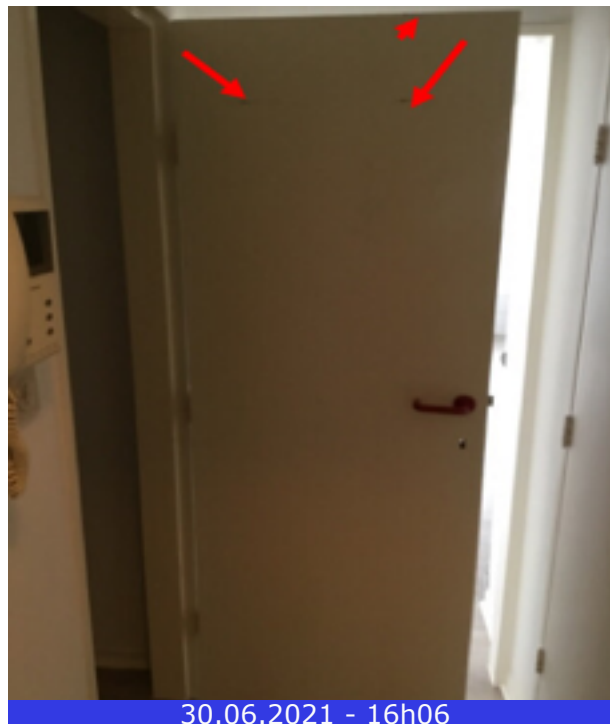
Photo 43 (Débarras / Porte(s) / Bon état)
