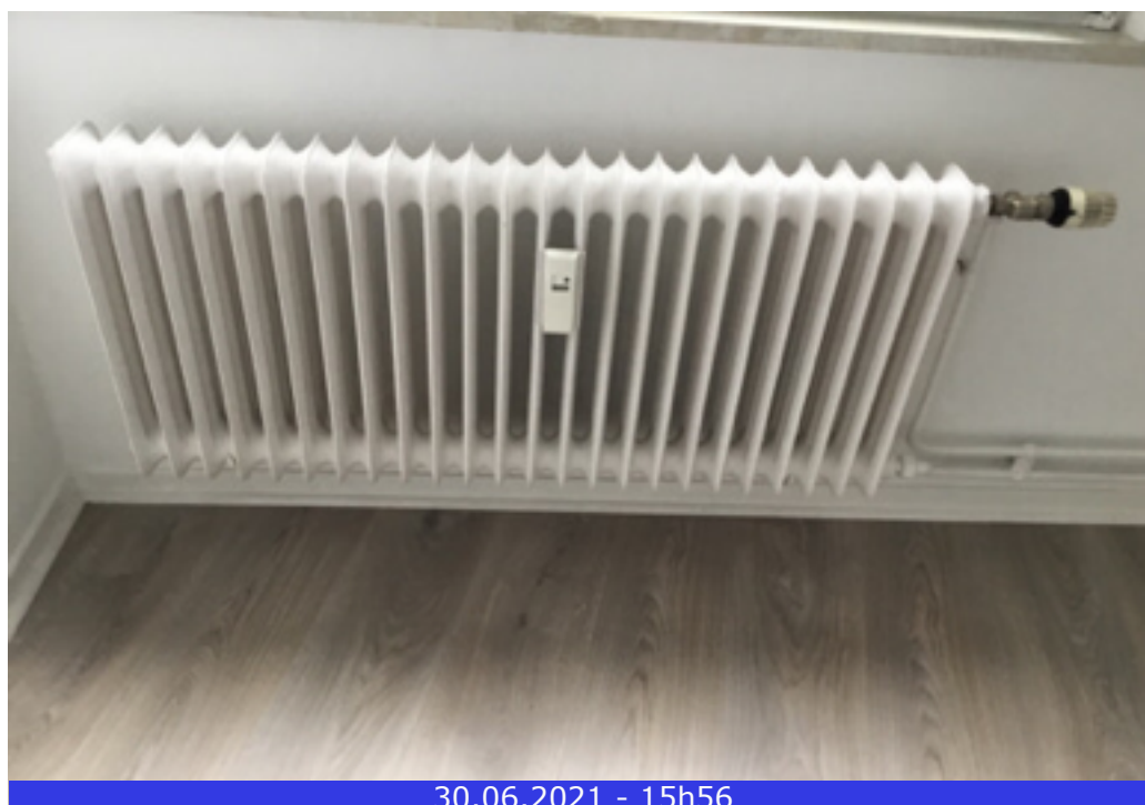
Photo 99 (Chambre (de derrière) / Radiateur(s) / Bon état)
