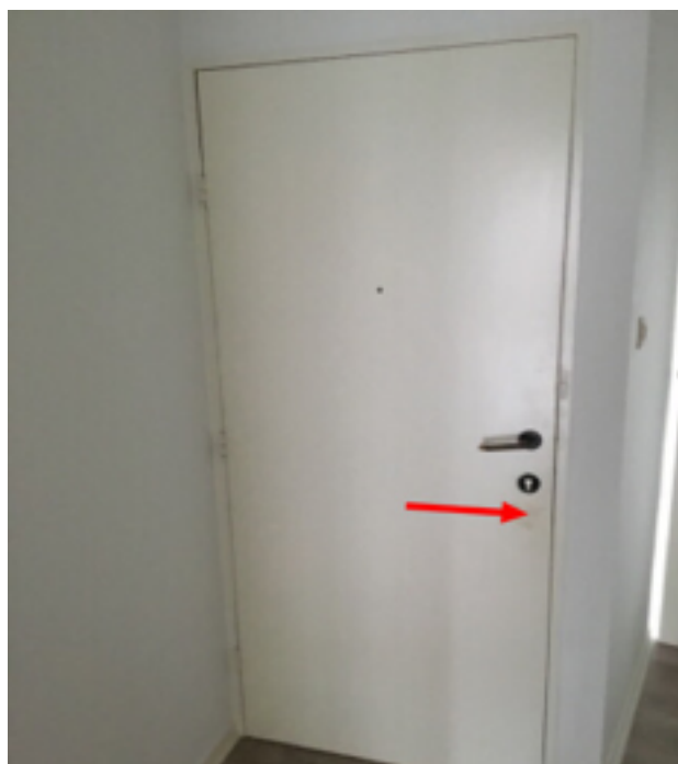
Photo 15 (Hall / Porte(s) / Bon état)
