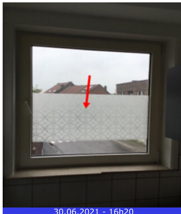
Photo 80 (Cuisine / Fenêtre(s) / Bon état)
