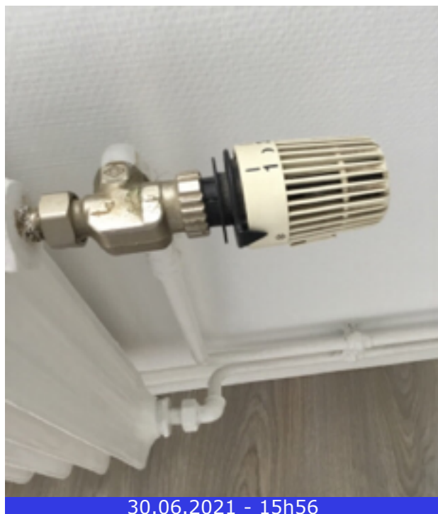
Photo 100 (Chambre (de derrière) / Radiateur(s) / Bon état)
