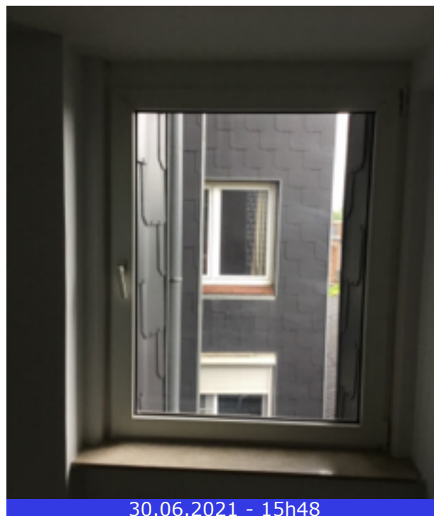
Photo 93 (Chambre / Fenêtre(s) / Bon état)
