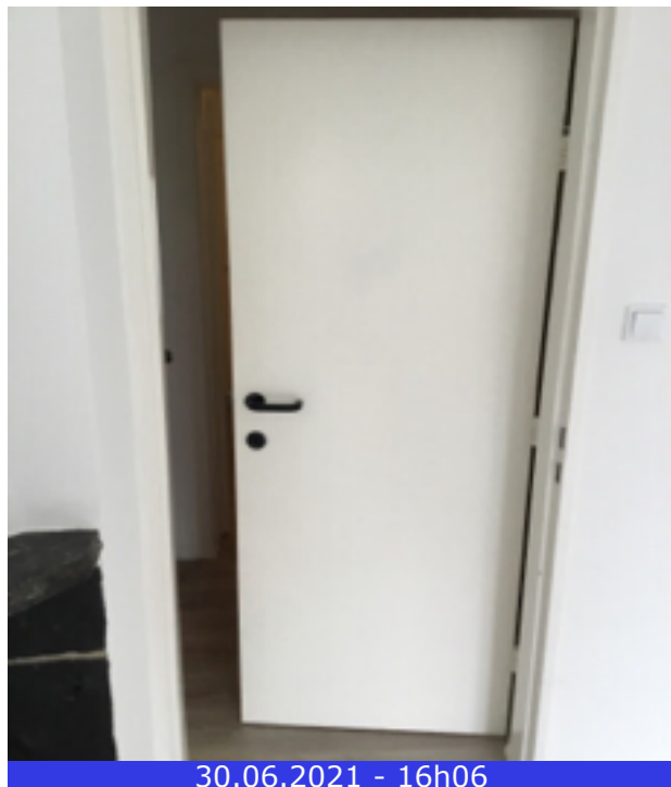
Photo 42 (Débarras / Porte(s) / Bon état)
