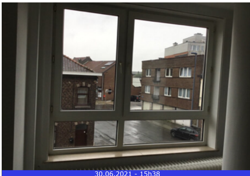
Photo 56 (Séjour / Fenêtre(s) / Bon état)
