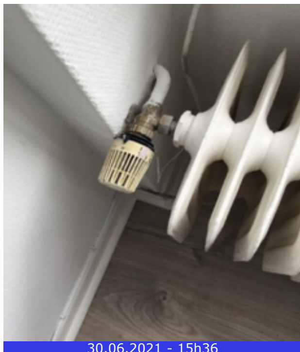
Photo 52 (Séjour / Radiateur(s) / Bon état)
