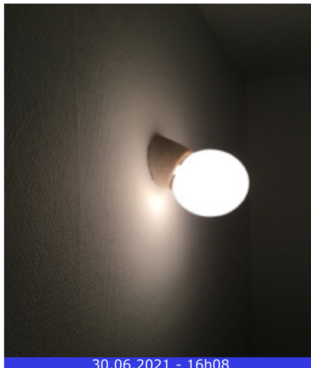
Photo 41 (Débarras / Point lumineux / Bon état)
