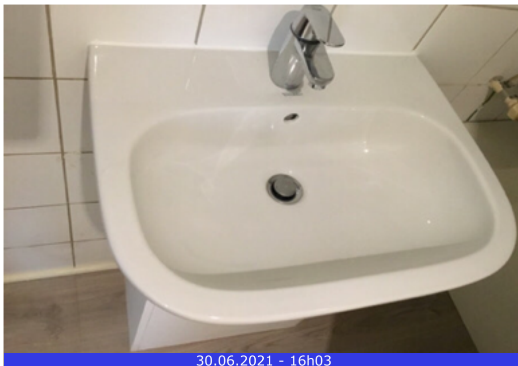
Photo 32 (Salle de bains / Lavabo / Bon état)
