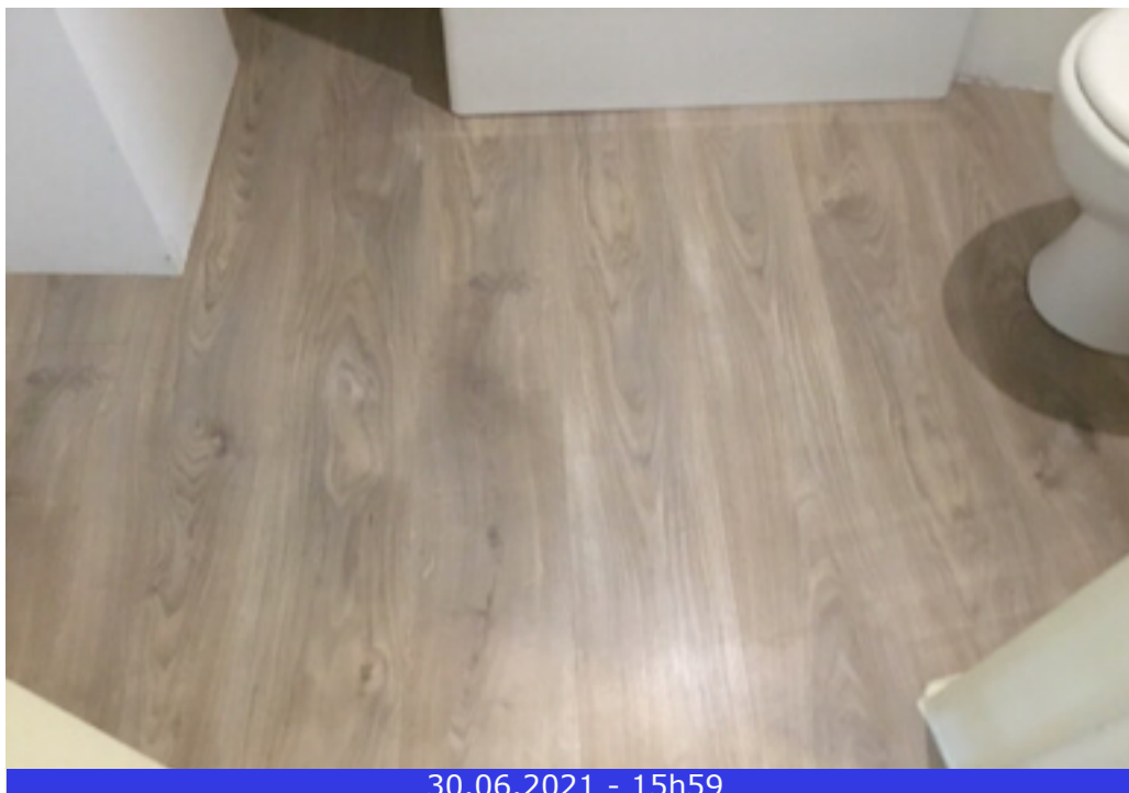
Photo 19 (Salle de bains / Sol / Bon état)
