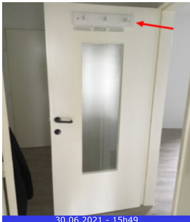
Photo 94 (Chambre / Porte(s) / Bon état)
