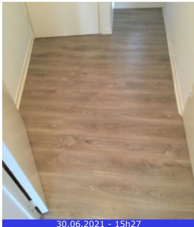
Photo 7 (Hall / Sol / Bon état)
