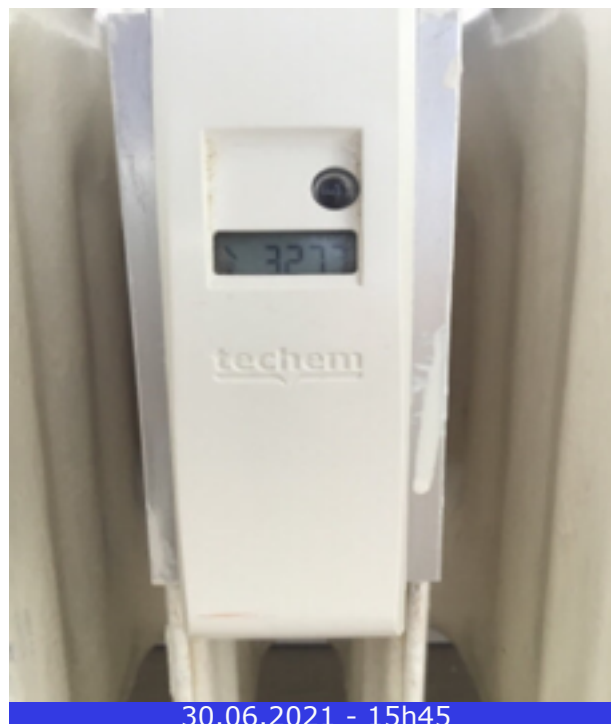
Photo 53 (Séjour / Radiateur(s) / Bon état)
