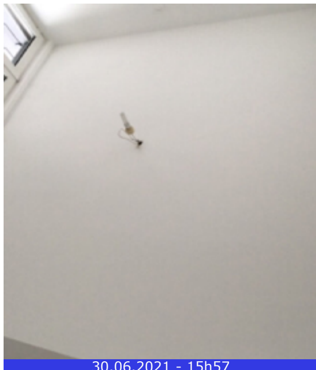
Photo 102 (Chambre (de derrière) / Plafond / Bon état)
