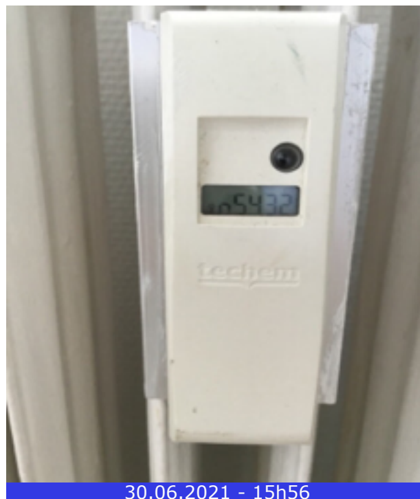
Photo 101 (Chambre (de derrière) / Radiateur(s) / Bon état)
