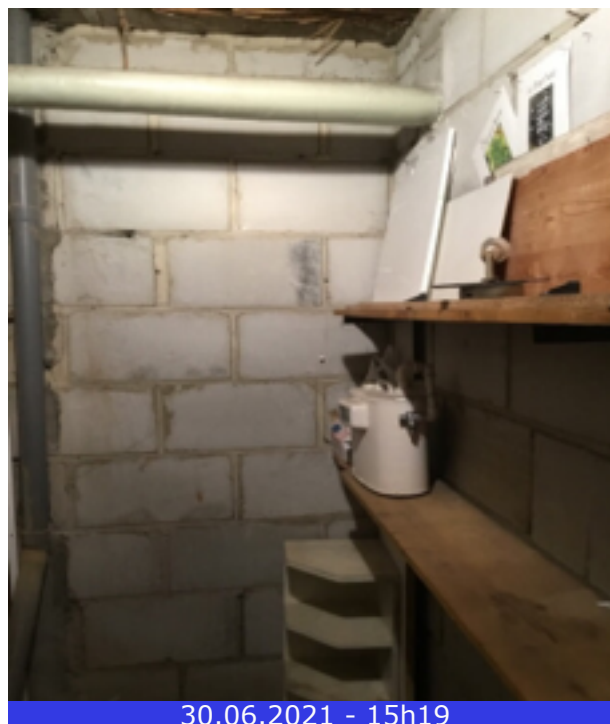
Photo 109 (Photo générale / Cave)
