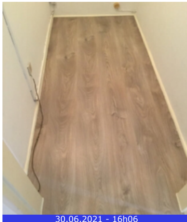
Photo 39 (Débarras / Sol / Bon état)
