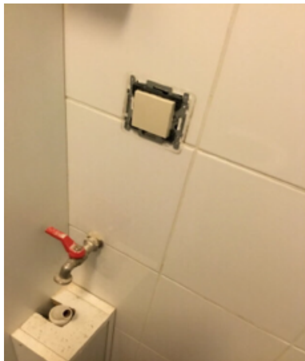
Photo 90 (Salle de bains / Interrupteurs / prises / Bon état)
