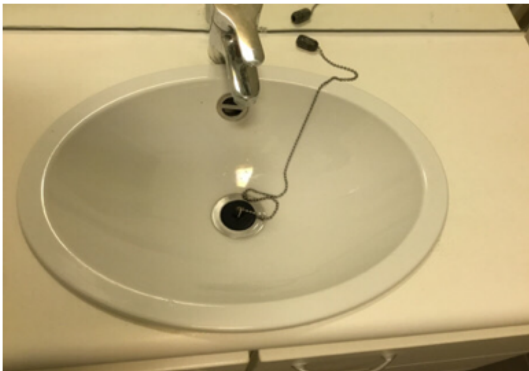
Photo 77 (Salle de bains / Lavabo / Bon état)
