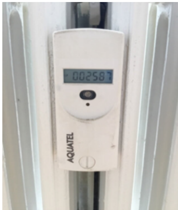
Photo 28 (Séjour / Radiateur(s) / Bon état)
