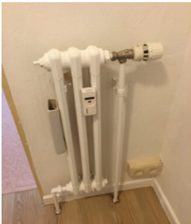
Photo 40 (Cuisine / Radiateur(s) / Bon état)
