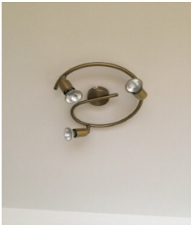
Photo 11 (Hall / Point lumineux / Bon état)
