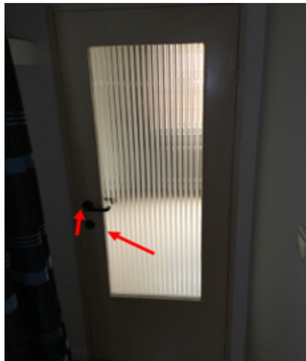
Photo 103 (Chambre / Porte(s) / Bon état)
