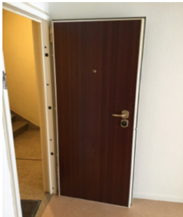
Photo 14 (Hall / Porte(s) / Bon état)
