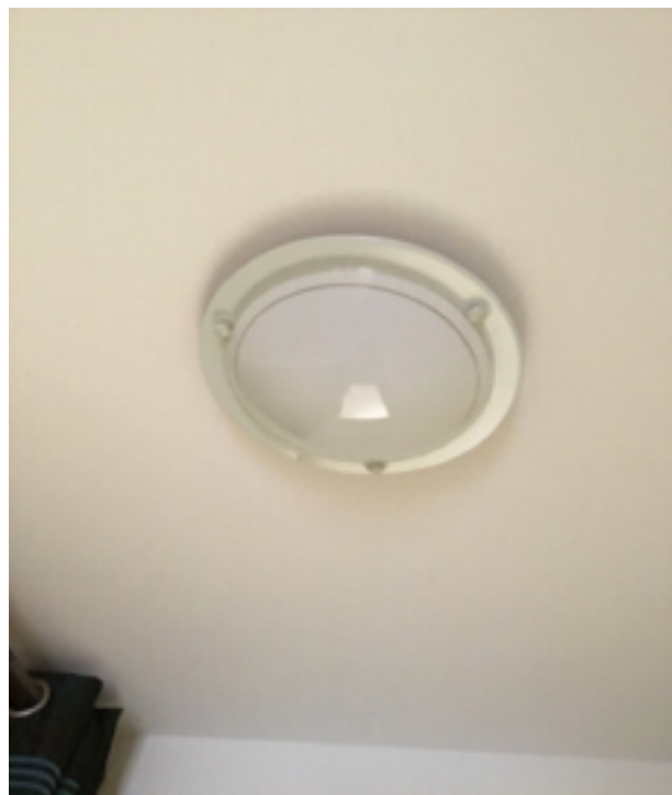
Photo 12 (Hall / Point lumineux / Bon état)
