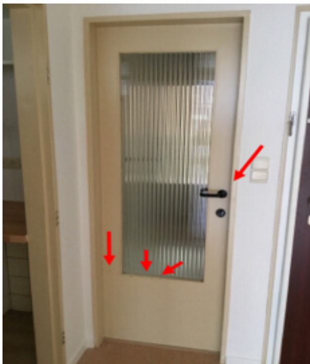
Photo 15 (Hall / Porte(s) / Bon état)
