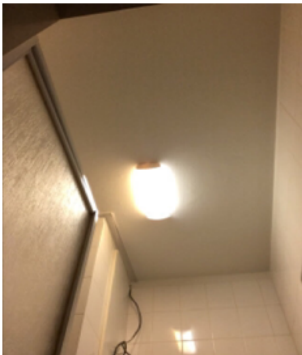
Photo 70 (Salle de bains / Plafond / Bon état)
