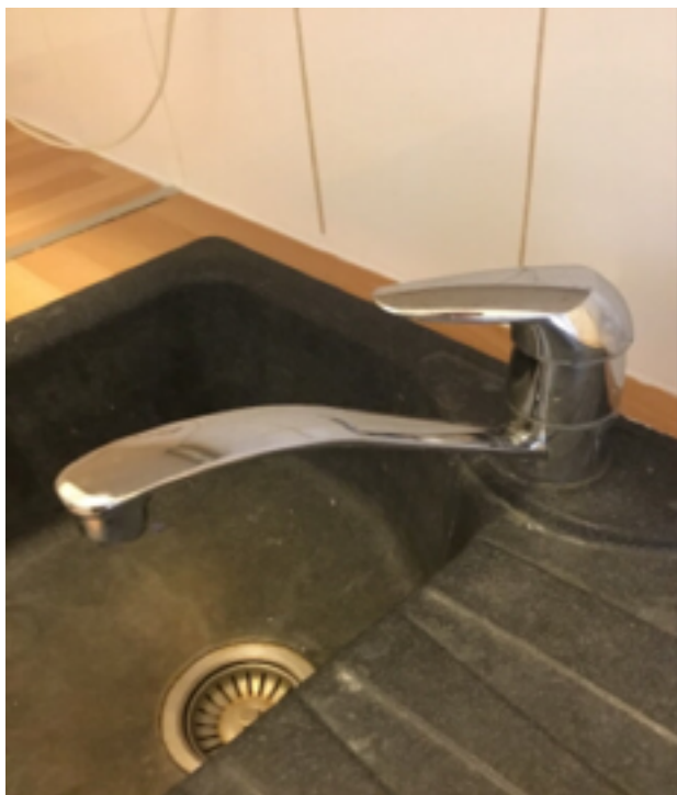
Photo 49 (Cuisine / Robinetterie / Bon état)
