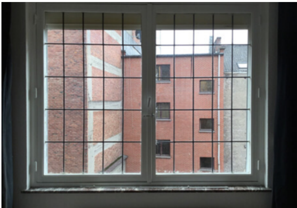
Photo 101 (Chambre / Fenêtre(s) / Etat d'usage)
