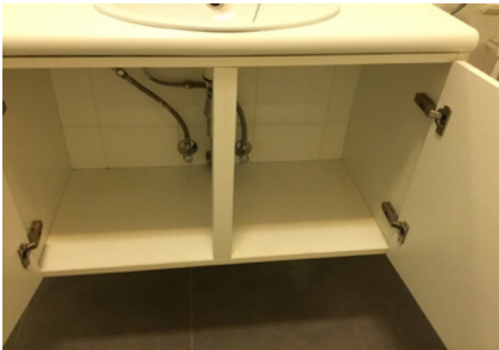
Photo 86 (Salle de bains / Meubles / Bon état)
