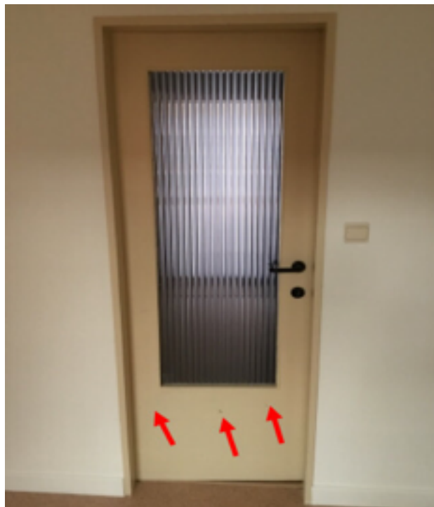
Photo 102 (Chambre / Porte(s) / Bon état)
