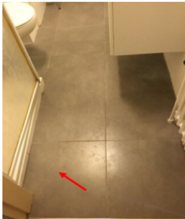
Photo 65 (Salle de bains / Sol / Bon état)
