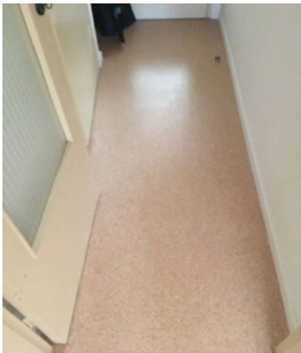
Photo 7 (Hall / Sol / Bon état)
