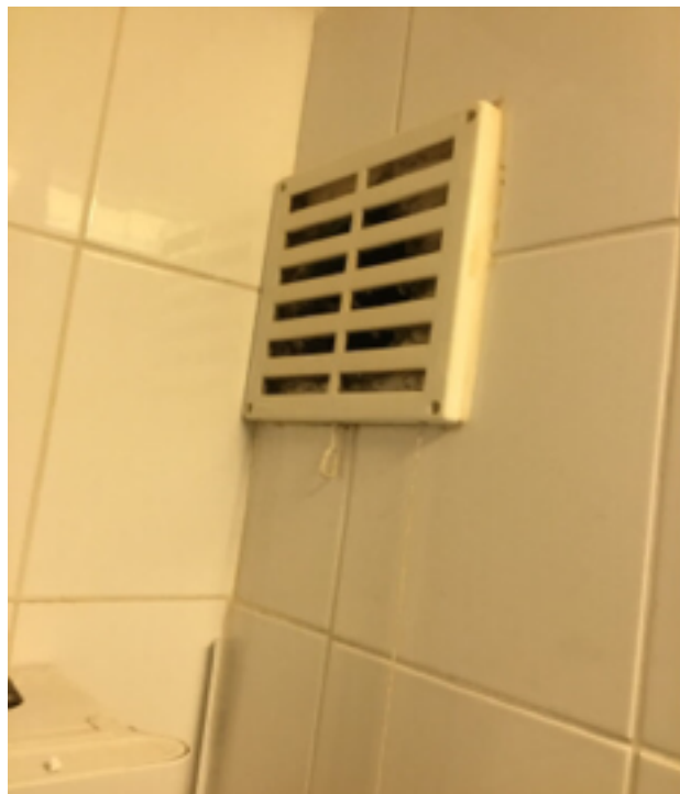
Photo 87 (Salle de bains / Ventilation / Bon état)
