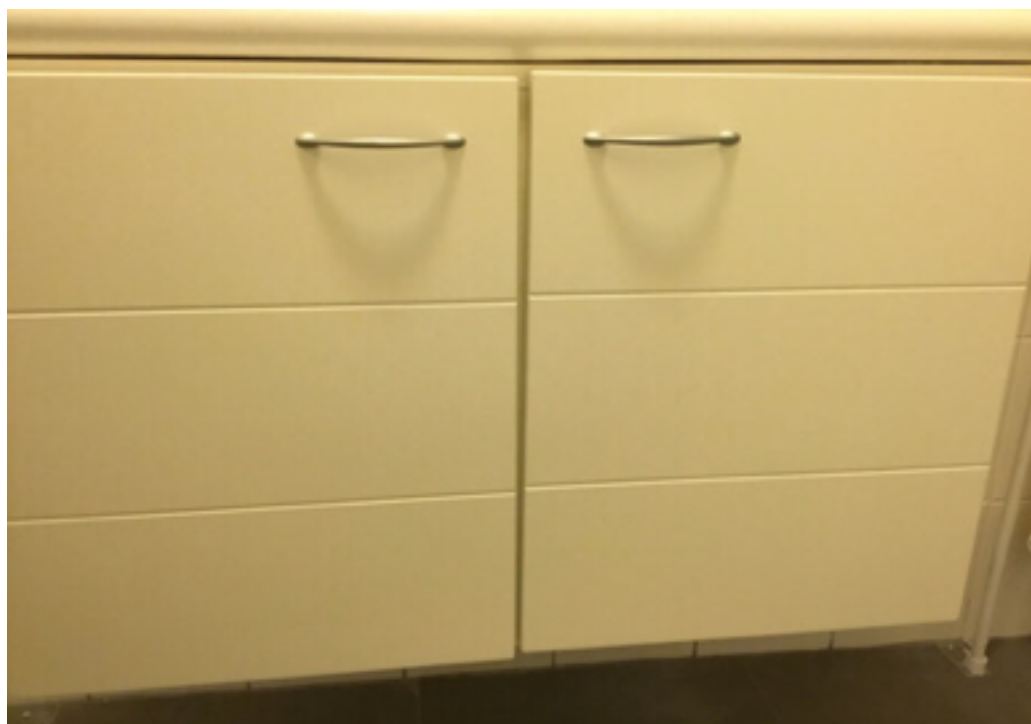
Photo 85 (Salle de bains / Meubles / Bon état)
