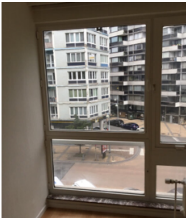
Photo 30 (Séjour / Fenêtre(s) / Bon état)
