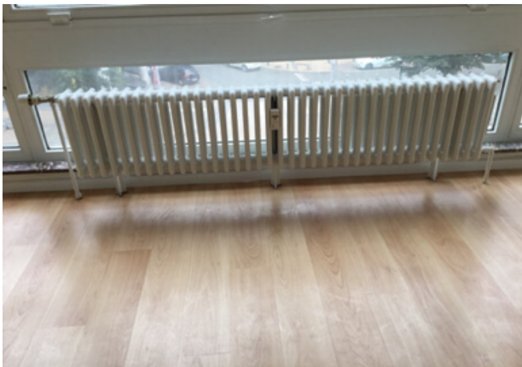
Photo 26 (Séjour / Radiateur(s) / Bon état)
