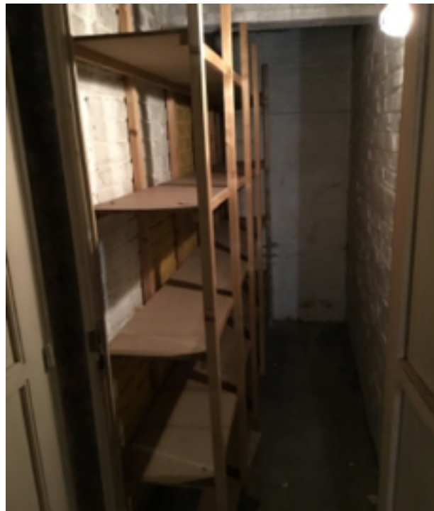
Photo 105 (Photo générale / Cave)
