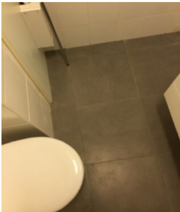
Photo 66 (Salle de bains / Sol / Bon état)
