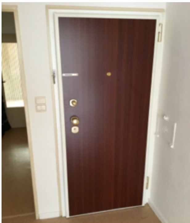
Photo 13 (Hall / Porte(s) / Bon état)
