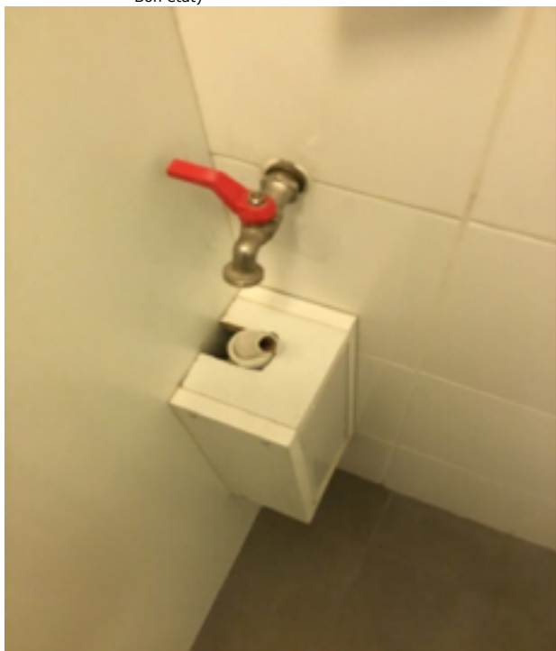
Photo 91 (Salle de bains / arrivée et évacuation d'eau / Bon état)
