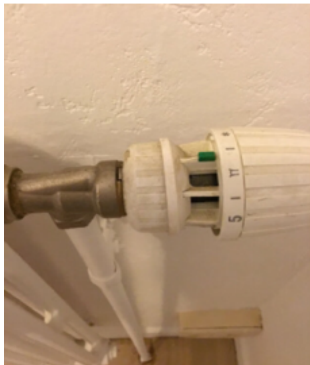
Photo 41 (Cuisine / Radiateur(s) / Bon état)
