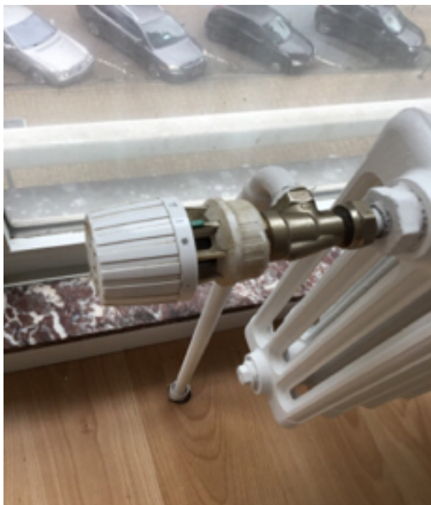
Photo 27 (Séjour / Radiateur(s) / Bon état)
