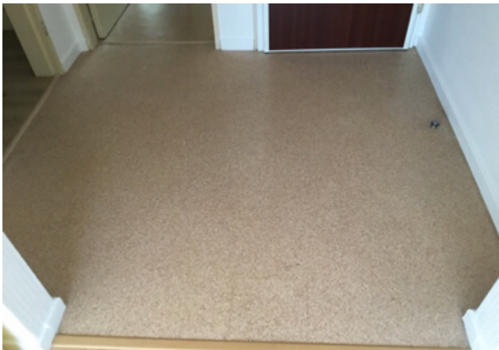
Photo 6 (Hall / Sol / Bon état)
