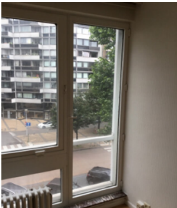
Photo 32 (Séjour / Fenêtre(s) / Bon état)
