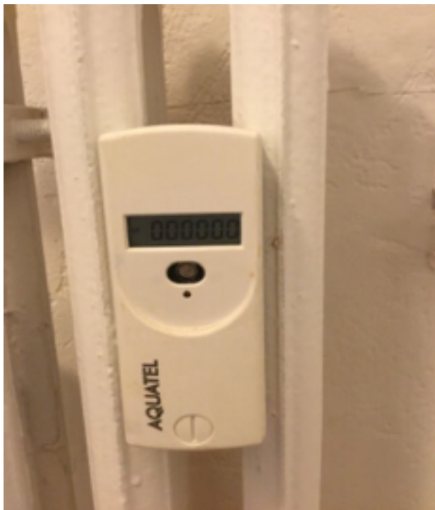
Photo 42 (Cuisine / Radiateur(s) / Bon état)
