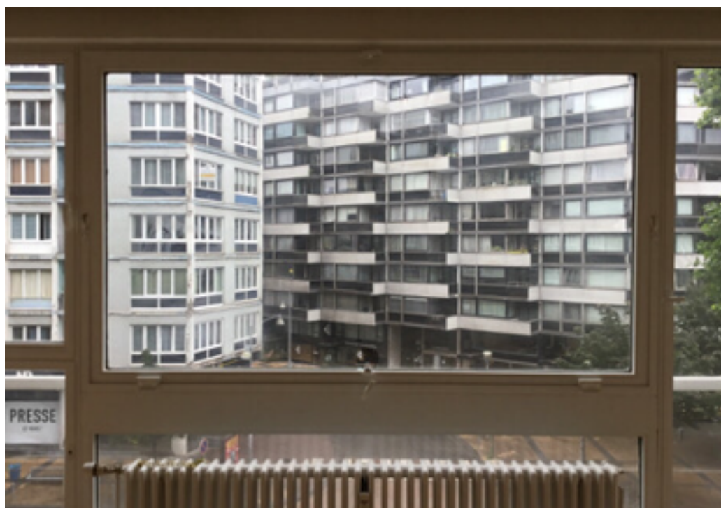
Photo 31 (Séjour / Fenêtre(s) / Bon état)
