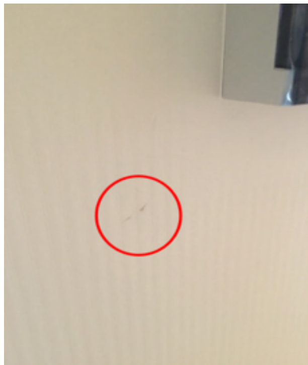
Photo 8 (Hall / Murs / Bon état)
