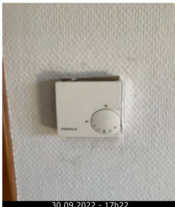
Photo 23 (Séjour / thermostat / Bon état)
