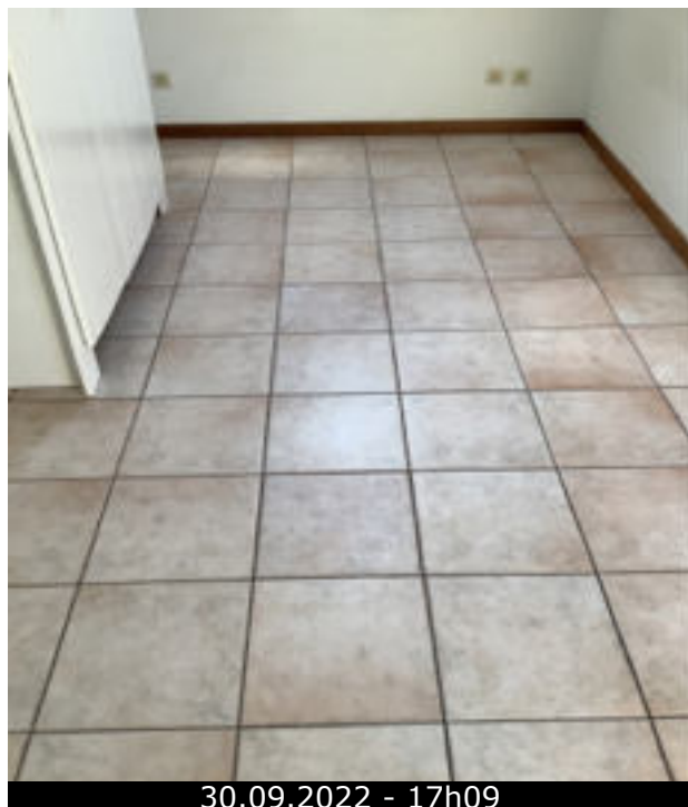
Photo 6 (Séjour / Sol / Bon état)
