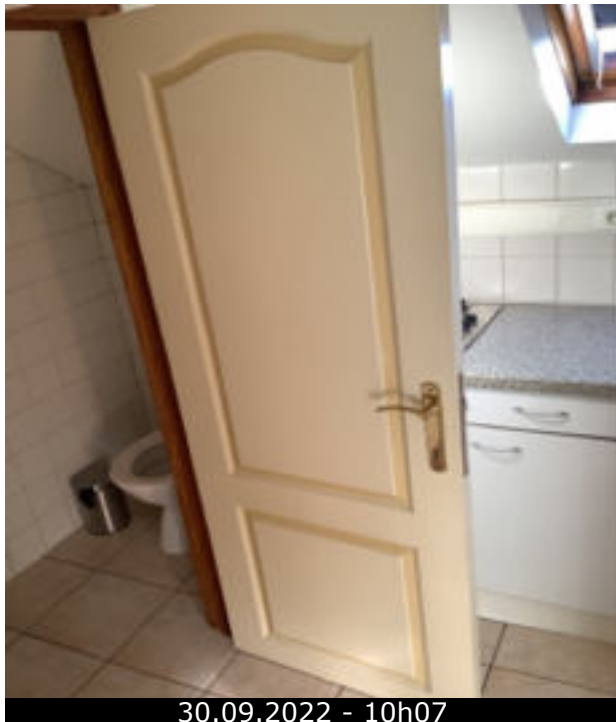
Photo 59 (WC / Porte(s) / Bon état)
