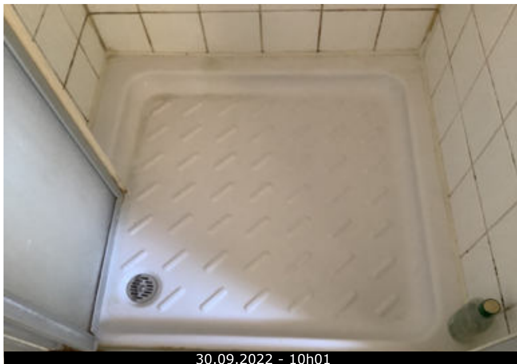
Photo 71 (Salle de bains / Douche / Bon état)
