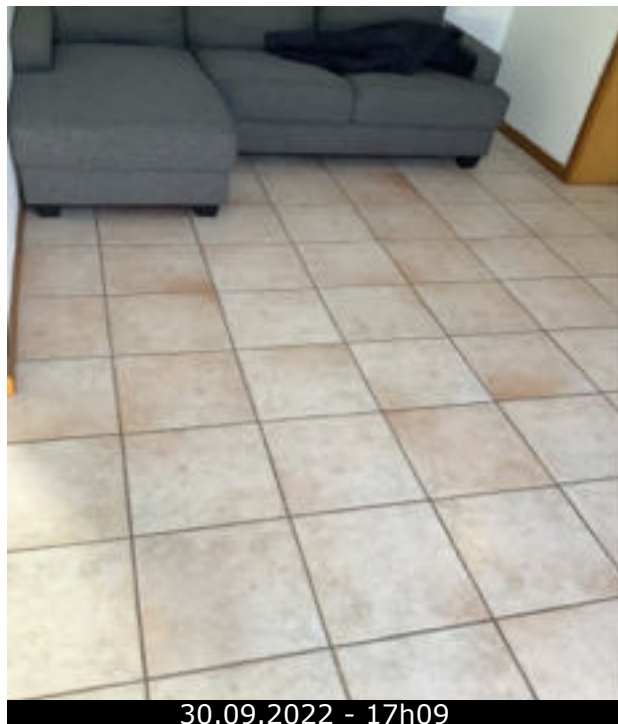
Photo 8 (Séjour / Sol / Bon état)
