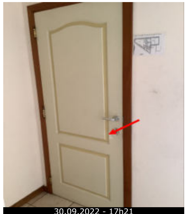
Photo 21 (Séjour / Porte(s) / Bon état)
