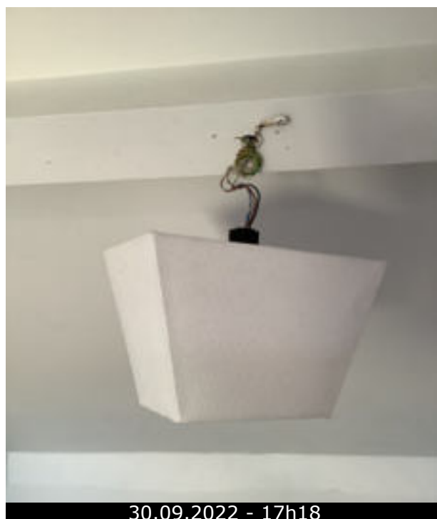
Photo 15 (Séjour / Point lumineux / Bon état)
