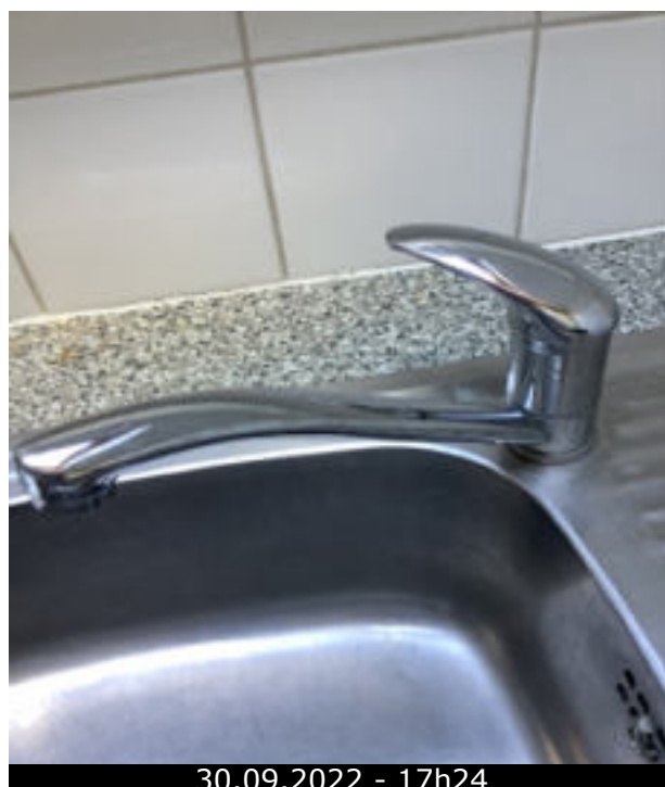
Photo 36 (Cuisine / Robinetterie / Bon état)
