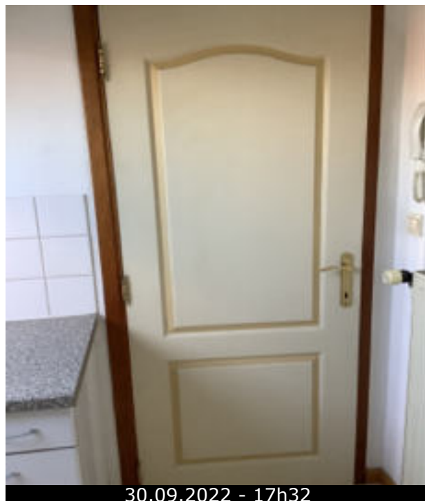
Photo 44 (Cuisine / Porte(s) / Bon état)
