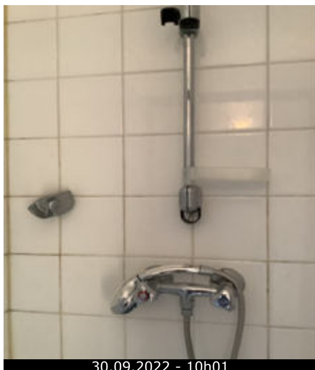
Photo 72 (Salle de bains / Douche / Bon état)
