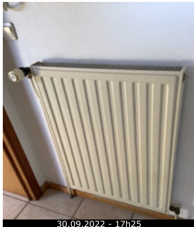
Photo 27 (Cuisine / Radiateur(s) / Bon état)
