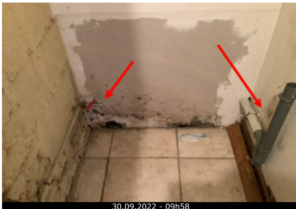
Photo 85 (Local technique / arrivée + évacuation d'eau / Bon état)
