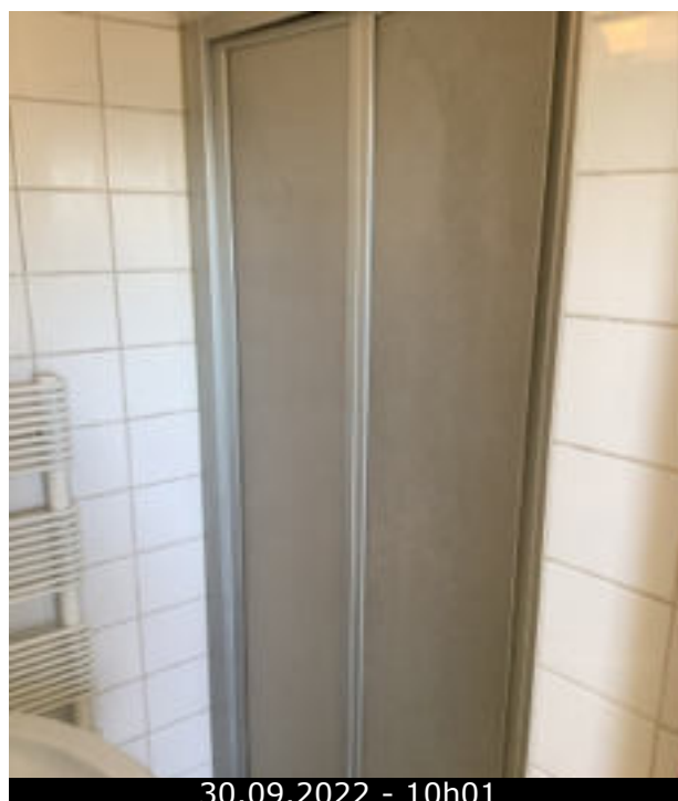
Photo 73 (Salle de bains / Douche / Bon état)
