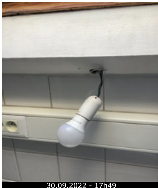
Photo 30 (Cuisine / Point lumineux / Bon état)
