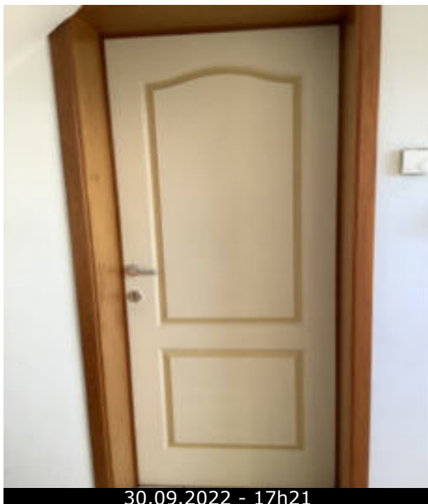
Photo 20 (Séjour / Porte(s) / Bon état)
