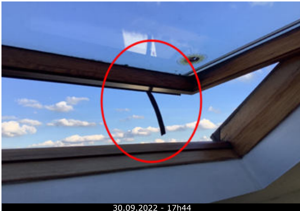
Photo 19 (Séjour / Fenêtre(s) / Bon état)
