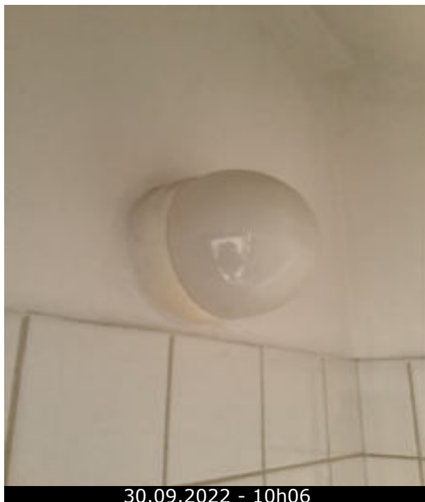
Photo 54 (WC / Point lumineux / Bon état)
