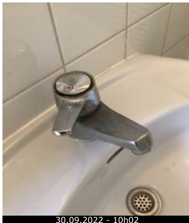
Photo 75 (Salle de bains / Robinetterie / Bon état)
