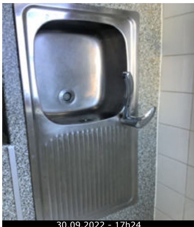
Photo 35 (Cuisine / Evier / Bon état)
