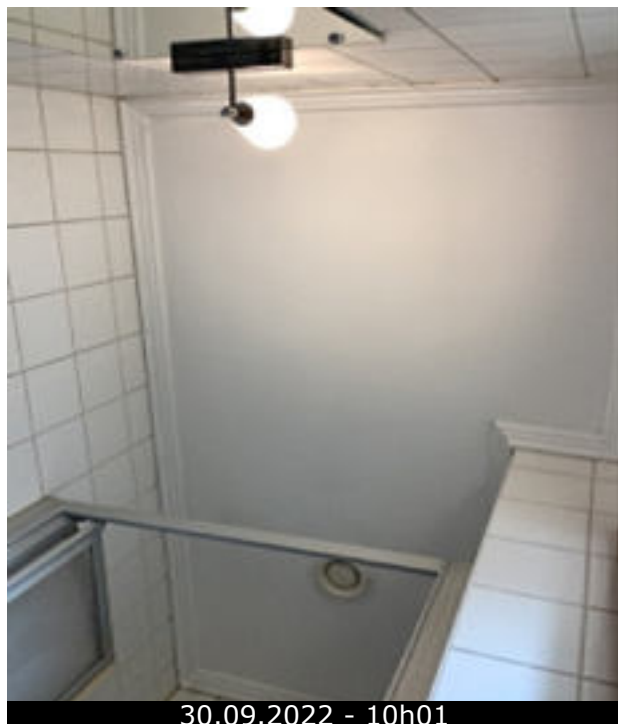
Photo 69 (Salle de bains / Plafond / Bon état)
