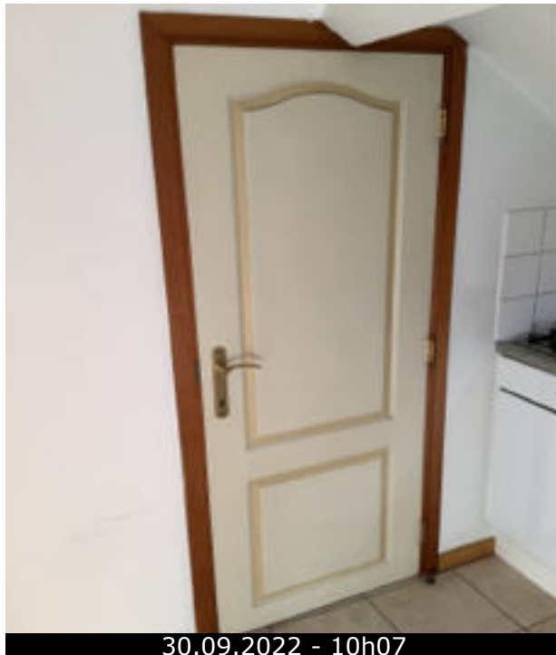
Photo 60 (WC / Porte(s) / Bon état)
