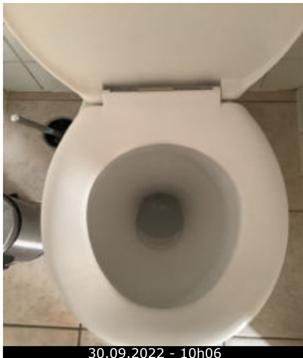
Photo 56 (WC / WC / Bon état)
