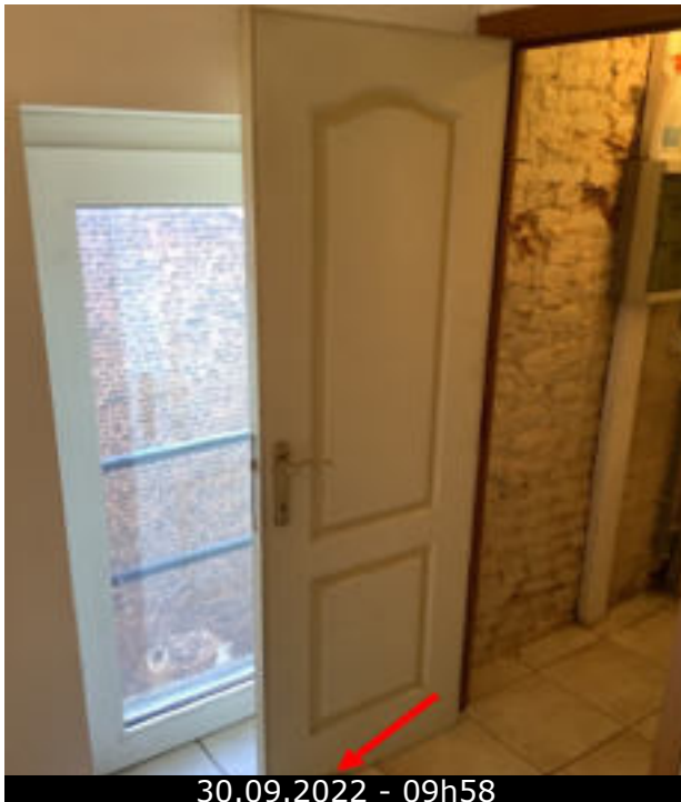
Photo 82 (Local technique / Porte(s) / Bon état)
