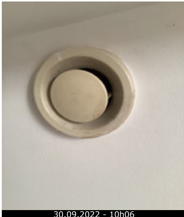
Photo 58 (WC / Ventilation / Bon état)
