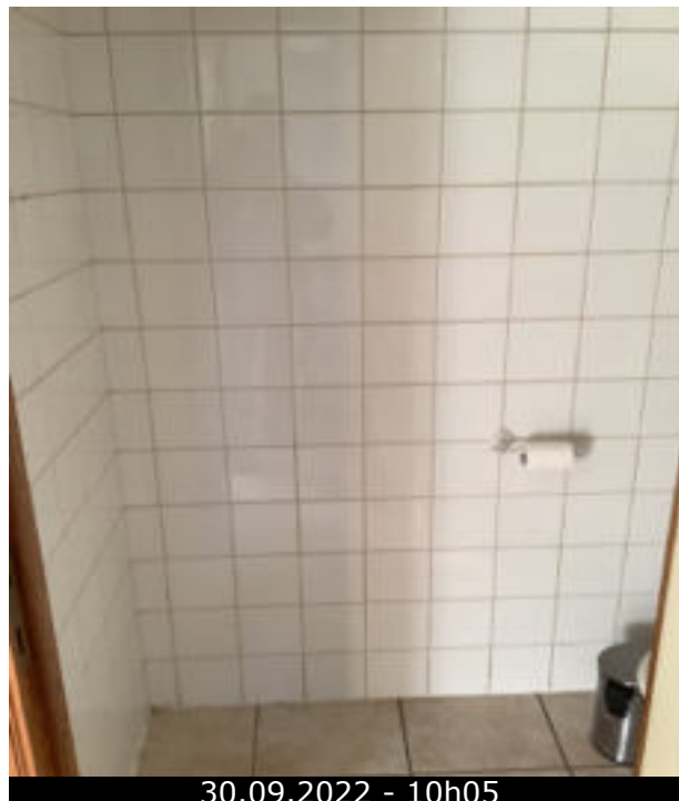
Photo 50 (Photo générale / WC)
