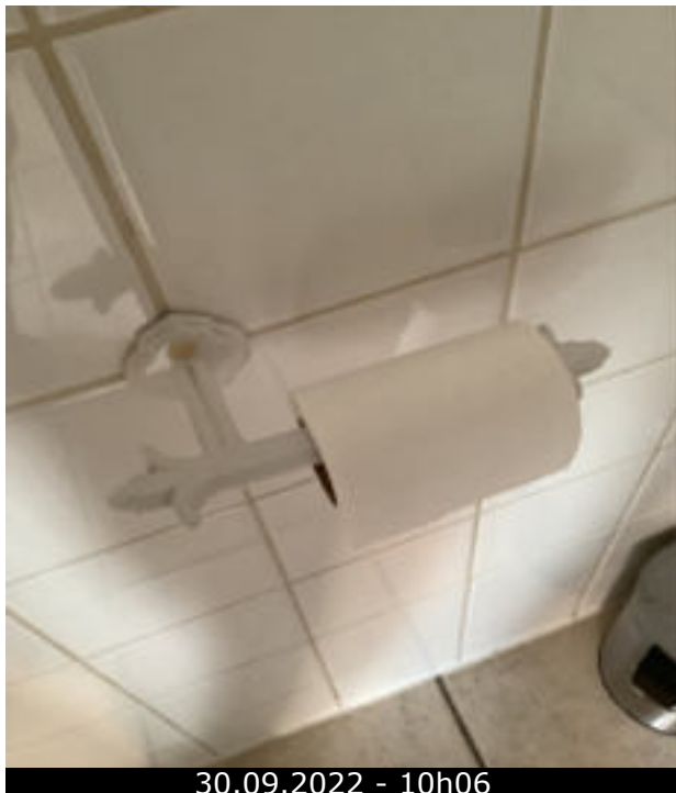
Photo 57 (WC / Accessoires / Bon état)
