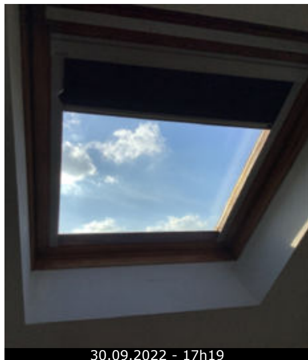
Photo 18 (Séjour / Fenêtre(s) / Bon état)
