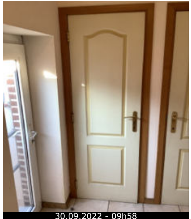
Photo 83 (Local technique / Porte(s) / Bon état)
