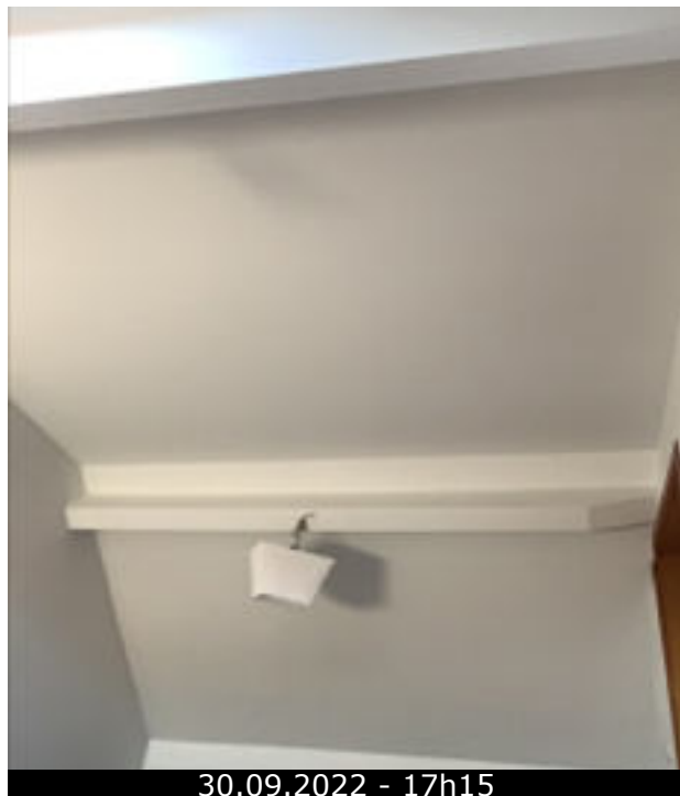
Photo 12 (Séjour / Plafond / Bon état)
