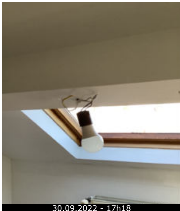
Photo 16 (Séjour / Point lumineux / Bon état)
