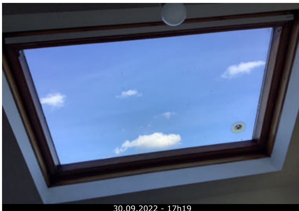
Photo 17 (Séjour / Fenêtre(s) / Bon état)
