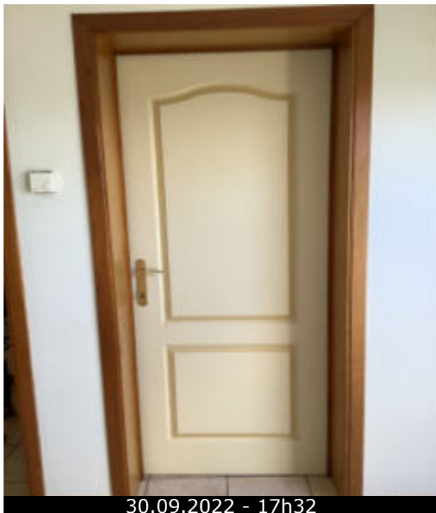
Photo 45 (Cuisine / Porte(s) / Bon état)
